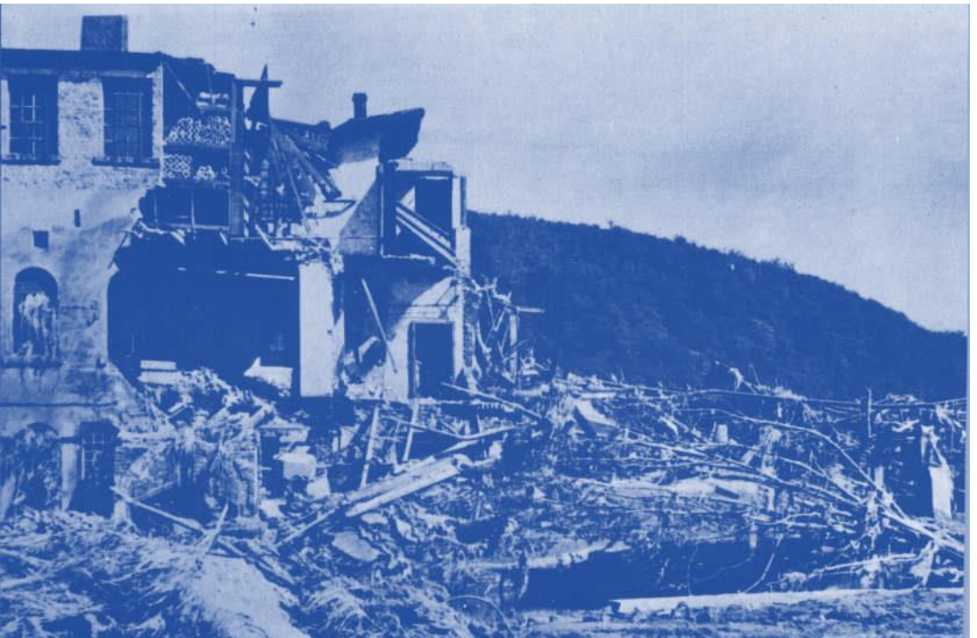
Eine total zerstörte Fabrik in Neheim-Hüsten. Gras in den Fabrikfenstern zeigt die Wasserhöhe an, die bis zur Fensterkante des 2. Stockwerkes reichte.
