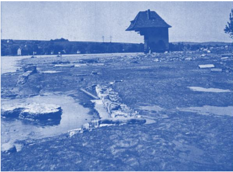
Neheim im Todestal. Häuser wurden von ihren Fundamenten glatt abrasiert. Tod und Zerstörung kamen diesmal von unten.
