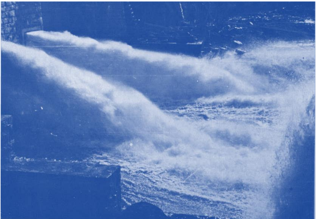
Neues Wasser für das Ruhrgebiet. Der Wiederanstau hat begonnen. Das Bild zeigt einen Probelauf der Ablassrohre.
