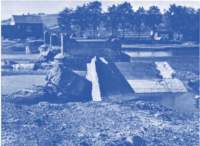
Strassenbrücke der B 63 von Wickede nach Menden. Im Vordergrund die zerstörte Ferngasleitung.
