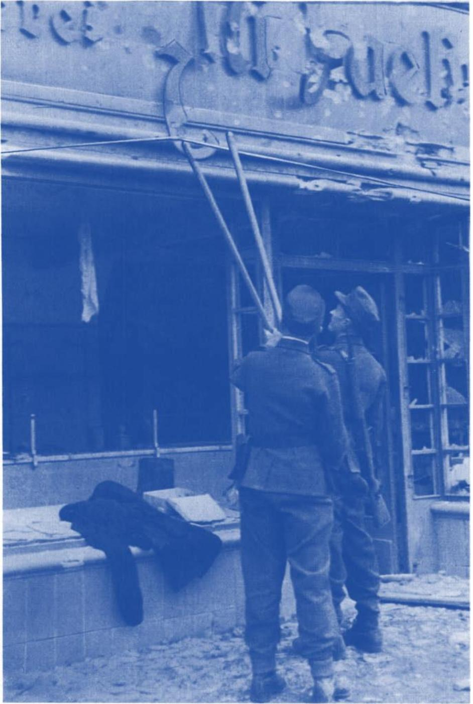
yj. Funker beim Hochlegen einer Verbindung aus schwerem Feldkabel
