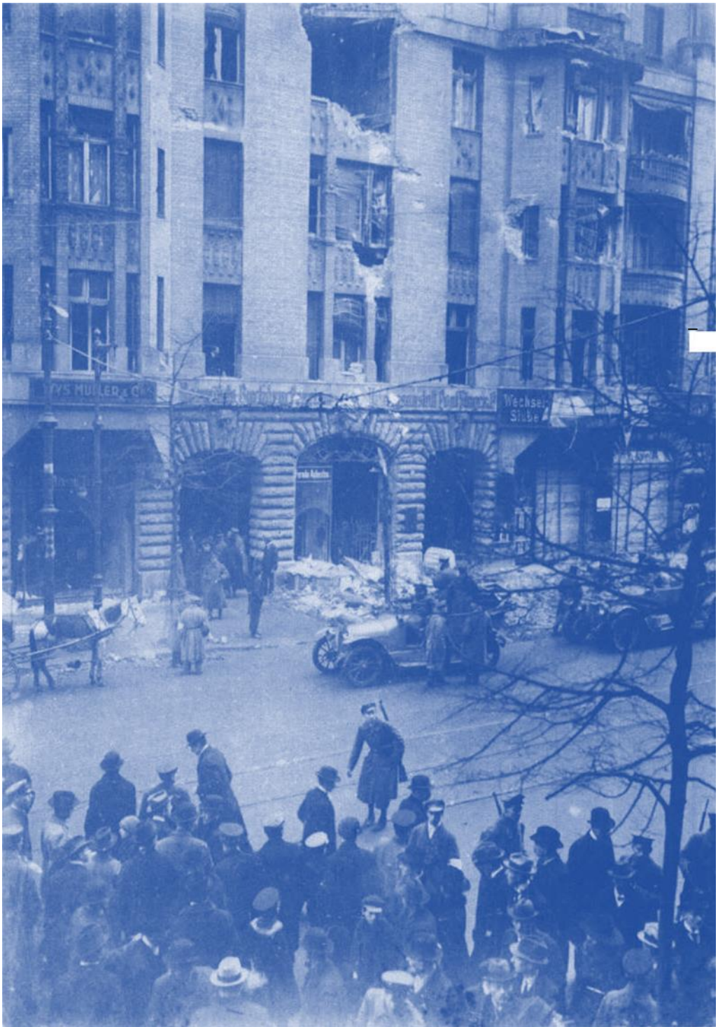
Das durch die Beschiessung zerstörte Gebäude des «Vorwärts».
