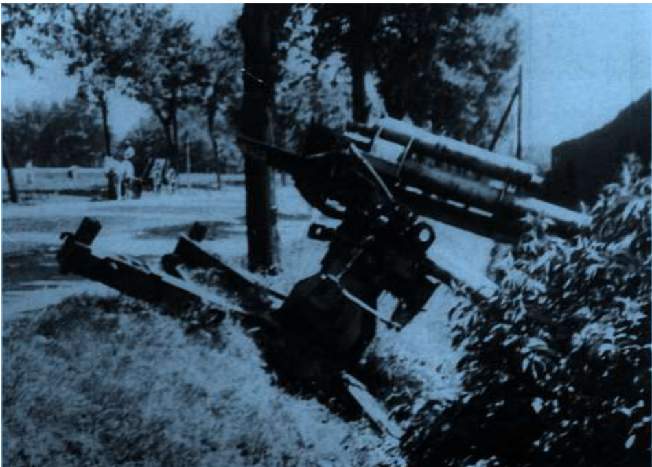
18 Ende Dresdner Flakbatterien nach dem Erdkampfeinsatz im «Ruhrkessel»; Geschütz «Heinrich», 3./565, gesprengt bei Kamen am 10. April 1945.
