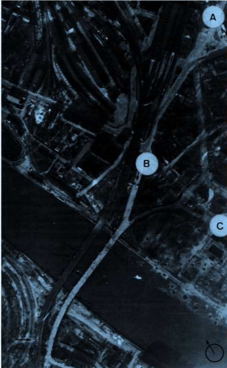
83 Eisenbahn- und Marienbrücke nach dem Angriff der amerikanischen 3. Luftdivision am 2. März 1945. Zahlreiche Bombentrichter auf dem Neustädter Ufer sind durch den hohen Wasserstand der Elbe verdeckt. Dampfzügen von Lokomotiven zeigen an, dass die Brücke am Tag der Fotografie (22.3.) wieder befahrbar war. A. Neustädter Bahnhof, B. Geöffnete Panzersperre in Brückenauffahrt, C. Japanisches Palais. Pfeile weisen auf Hauptschadensstellen beider Brücken.
