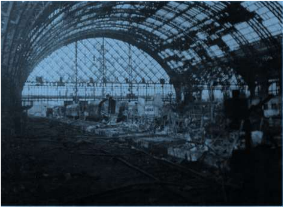
63 Ausgebrannte Züge in der Haupthalle des Hauptbahnhofs.
