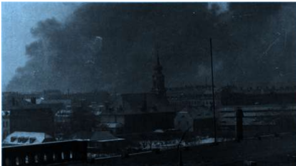
26 Brände im Stadtteil Cotta und im Verschiebebahnhof Friedrichstadt. Bildmitte die barocke Matthäuskirche. Sie wurde am Mittag des 14. Februar 1945 zerstört.
