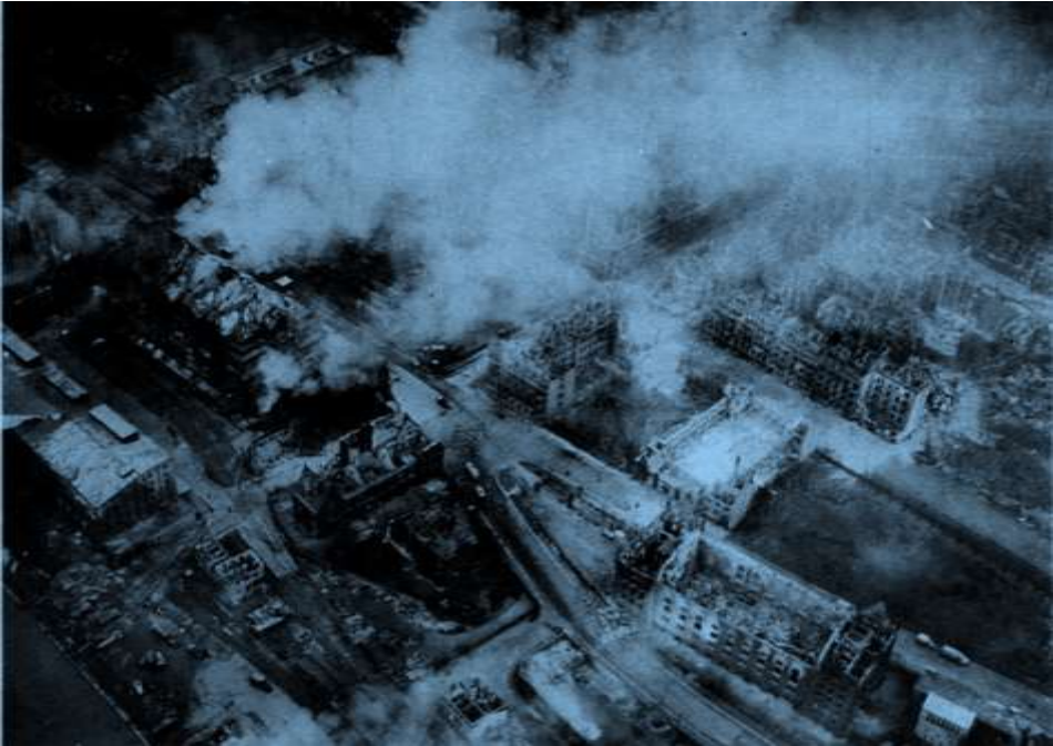
47 (oben) Der grosse Speicher in der Devrientstrasse brennt noch. Feuerwehren versuchen Wasser aus der Elbe zu pumpen.
