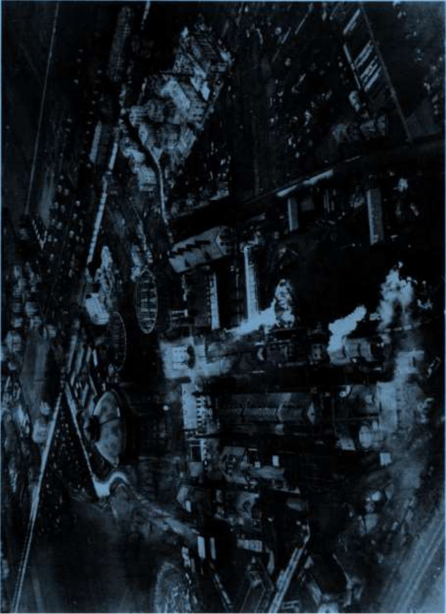
52 Im Gaswerk Reick brennen noch die Kokshalden. Der grosse, mit Tarnfarbe gestrichene Gasbehälterbau ist unbeschädigt, die zwei kleineren Gasometer sind ausgebrannt. Dahinter ein Barackenlager. Von links oben nach rechts unten verläuft die Winterbergstrasse, darüber die leeren Geschützwälle der abgezogenen Flakbatterie 238/IV, Liebstädter Strasse.
