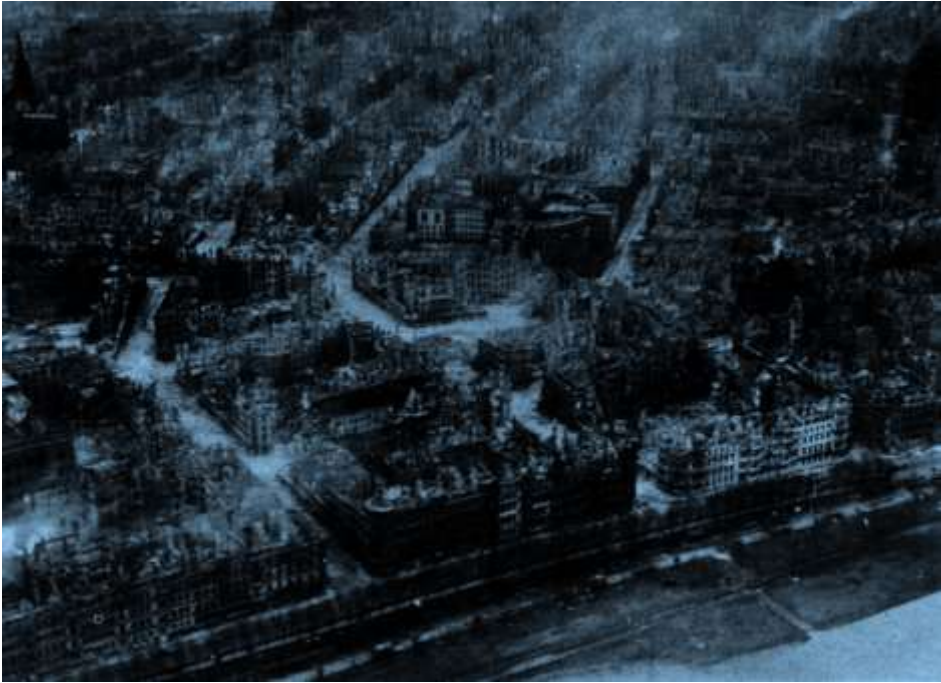
49 Leergebrannte Häuser soweit das Auge blickt. Vorn: Elbe, Terrassenufer. Mitte: Marschallstrasse, Mathildenstrasse. Hinten links: Johanneskirche.
