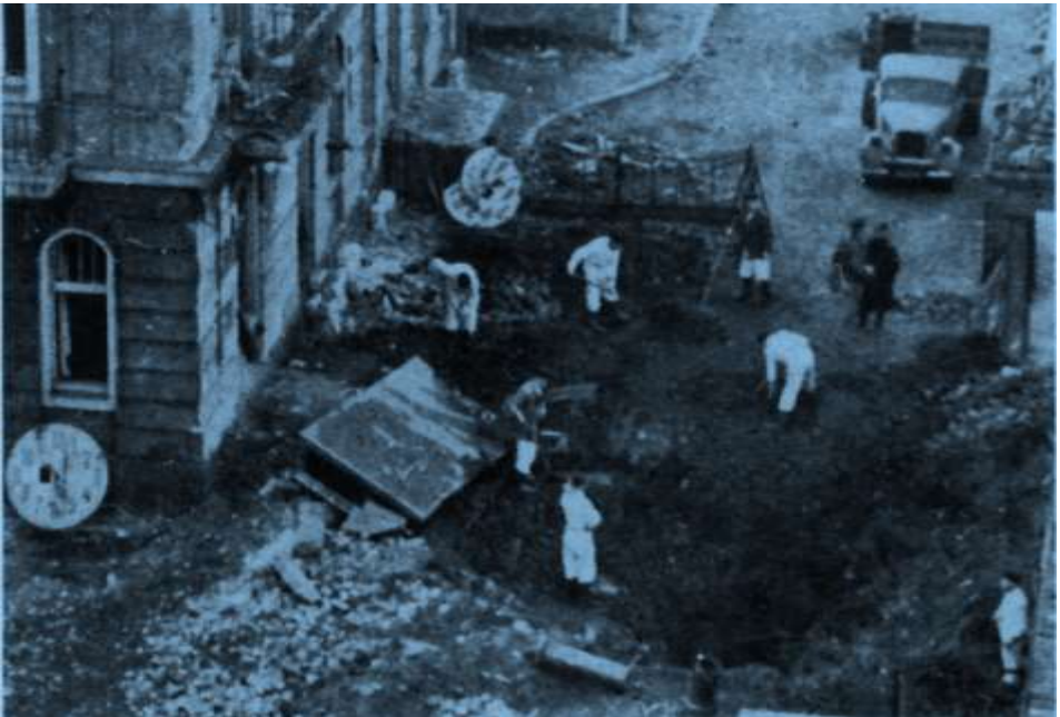
74 Einheiten der Technischen Nothilfe und des Instandsetzungsdienstes beseitigten die größten Schäden, um die Versorgung mit Strom und Wasser wiederherzustellen und die Kanalisation zu regulieren. Hilfe kam überwiegend von ausserhalb. Sogar Bergwerkfachtrupps waren eingesetzt.
