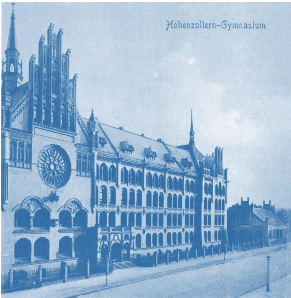
Abb. 85 Das Hohenzollern-Realgymnasium, später Scharnhorst-Schule, heute Riesengebirgs-Oberschule, in der Belziger Strasse, 1905
