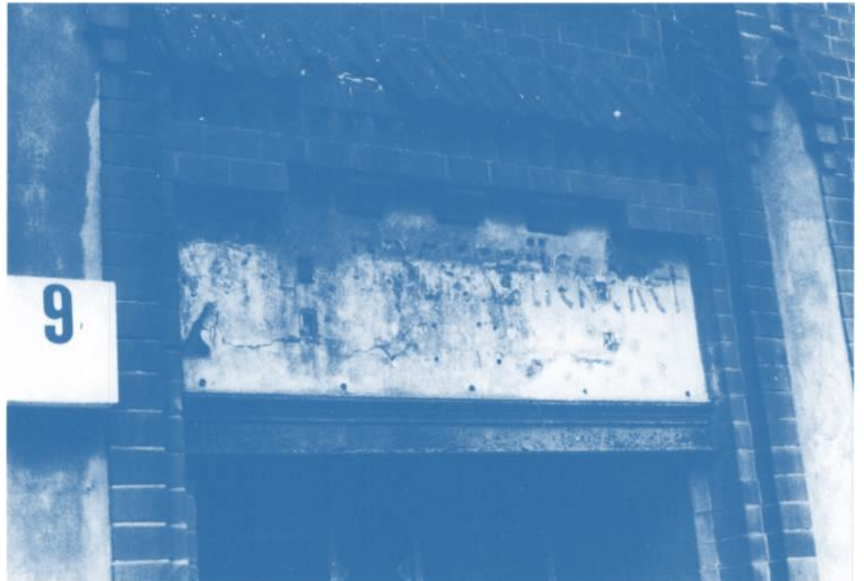
Abb. 71 Spurensicherung über dem Eingang in der Ebersstrasse 9
