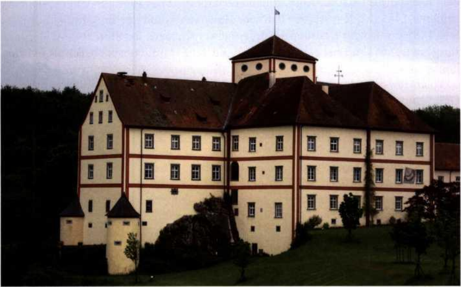
Schloss Langenstein. Umbaut von frühneuzeitlichen Gebäuden blieb der Hauptturm (1. Hälfte 13. Jh.) mit seiner Wackenverkleidung erhalten, er wurde barock aufgestockt. (Foto: Verfasser)
