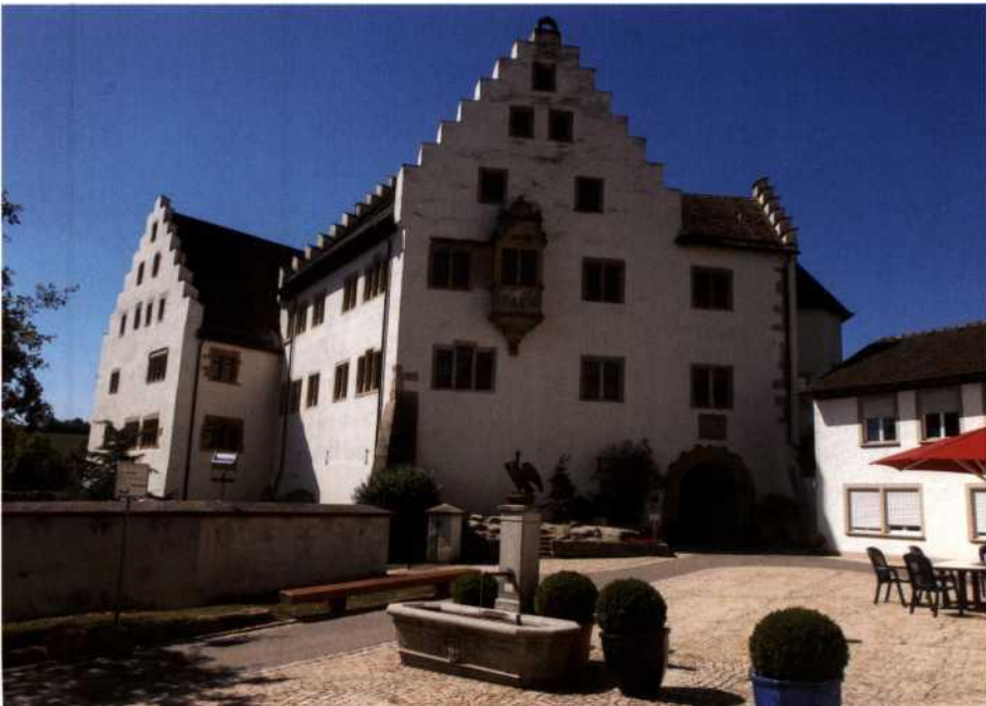
Deutschordensschloss Blumenfeld. Zweiphasiges Hauptgebäude mit Stufengiebeln, Renaissance-Erker und (erneuertem) rustiziertem Portal (Foto: Verfasser)
