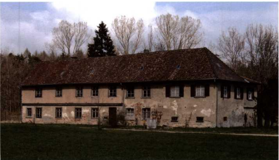
St. Katharina im Mainauwald, Südwestansicht, Zustand 2004, rechts die Überreste der ehem. Klosterkirche (Foto: Verfasser)
