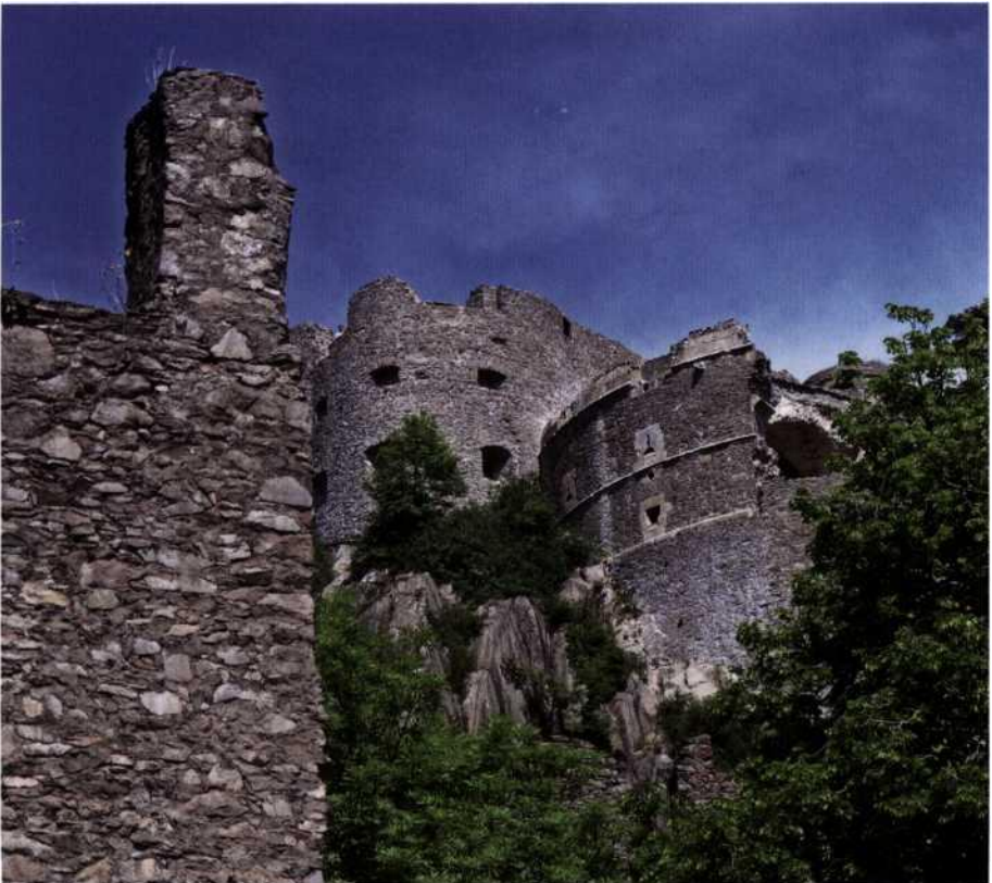
Festung Hohentwiel. Feldseitige Ansicht des Rondells Augusta (16. Jh.), links dahinter ein älterer Geschützturm (Foto: Verfasser)
