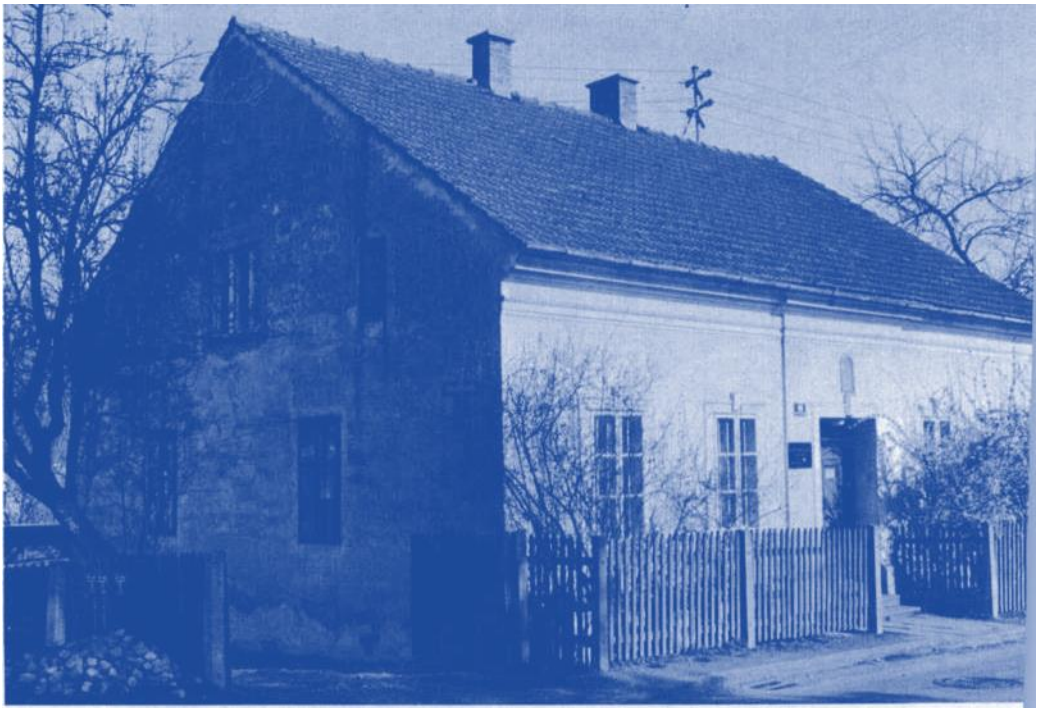
Abb. 13. Das Hitler-Haus in Leonding bei Linz. Es beherbergt gegenwärtig die Praxis des Gemeindefarztes, die Behandlungsräume und die Wohnung des Arztes. Nur die Strasse trennt das Gebäude vom Friedhof, auf dem die Eltern Adolf Hitlers bestattet sind.
