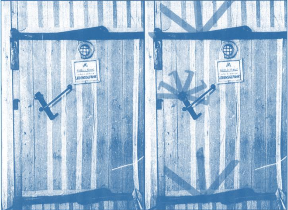
Abbildungen 10a&b: «Gasdichte» Tür aus Holz mit Guckloch und Schutzgitter, «abgedichtet» mit Filzstreifen; sie wurde für eine Entwesungskammer im Lager Auschwitz benutzt. Sie wurde von der Häftlingsschreinerei gebaut und hatte drei Riegel aus Flacheisen. Ihr Bewegungsradius ist im rechten Bild gezeigt.
