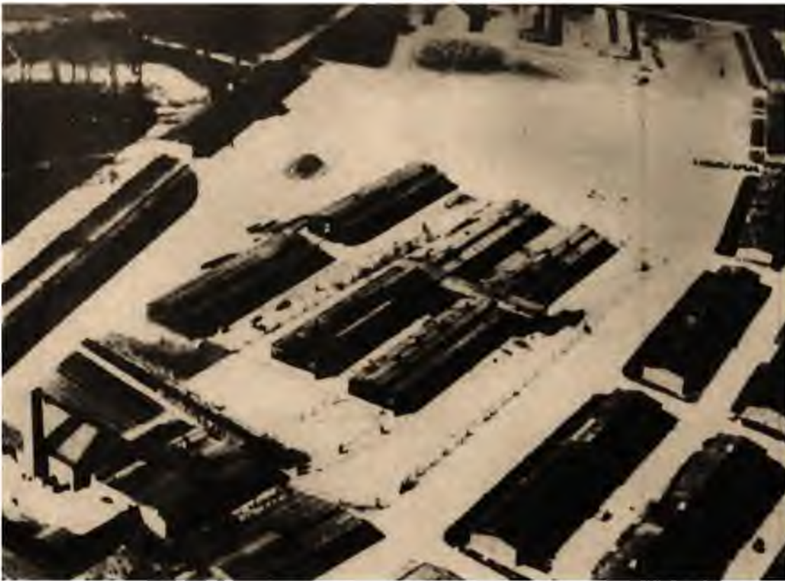
Gebäude zur probeweisen Montage des Karabiners 98k neben dem Appellplatz (später DAW-Schlosserei), 1942
