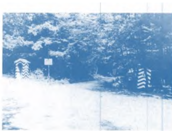
Eingangsbereich in das abgesperrte Baugelände, 9.7.1937
