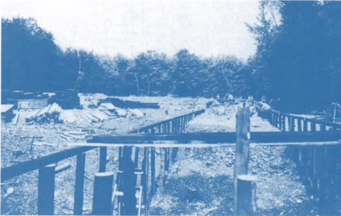
Bau des Fundaments für die erste Baracke, 9.7.1937
