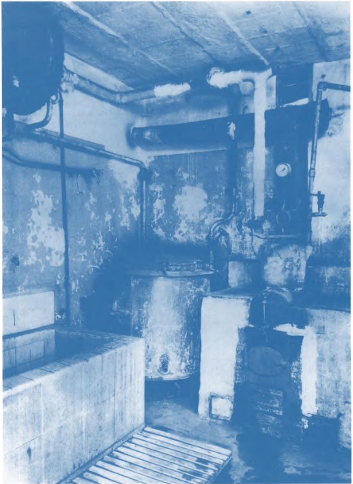
Keller der ehemaligen Häftlingskantine. Hier, wo ein Behelfslabor zur Erzeugung von Toilettenartikeln für die SS eingerichtet worden war, stellten der sowjetische Häftling Pawel Lysenko und sein polnischer Kamerad Tdzistaw Lewandowski im Auftrag der Leitung der Militärorganisation Sprengstoff und Handgranaten her.
