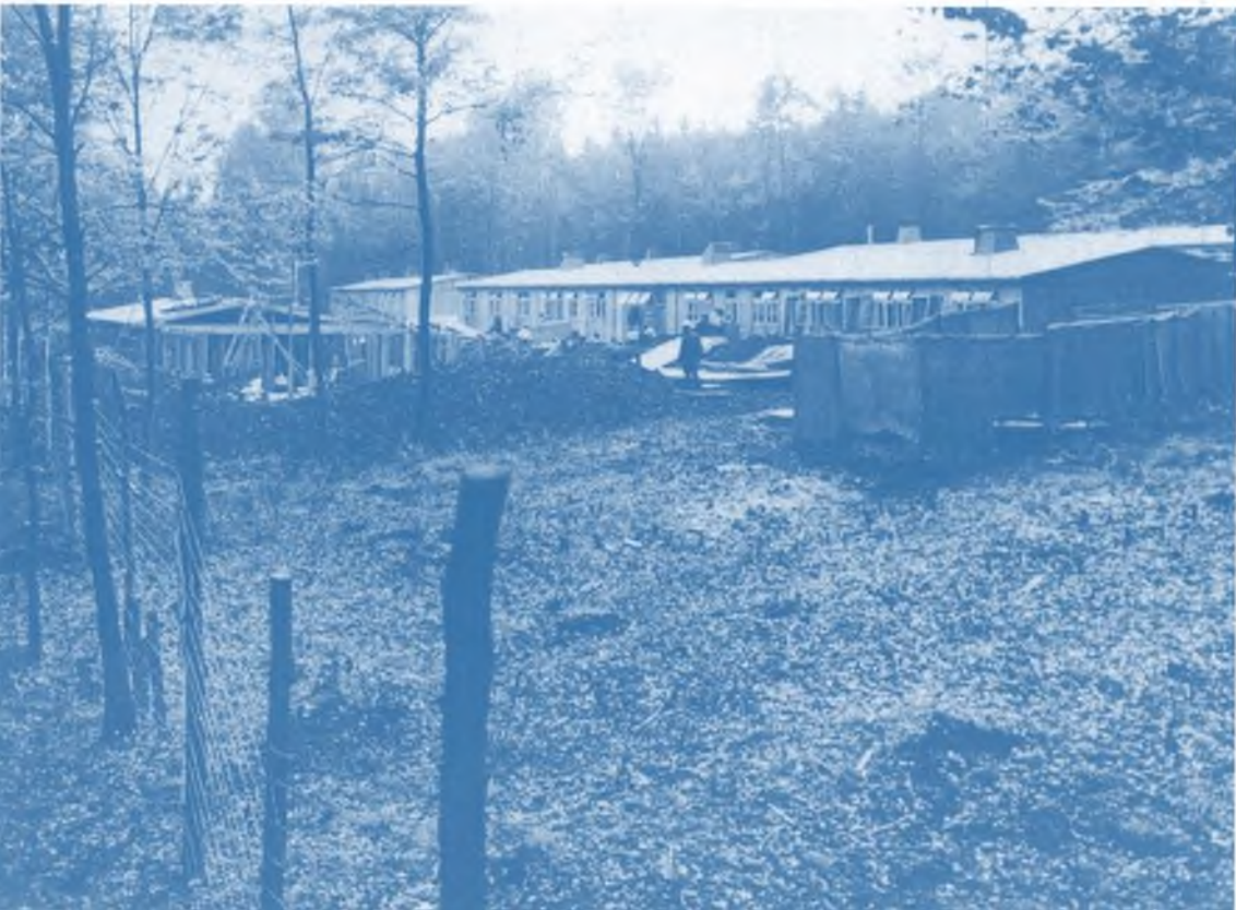
Häftlinge bei Vermessungs- und Schachtarbeiten zum Bau neuer Baracken, 23.7.1937
