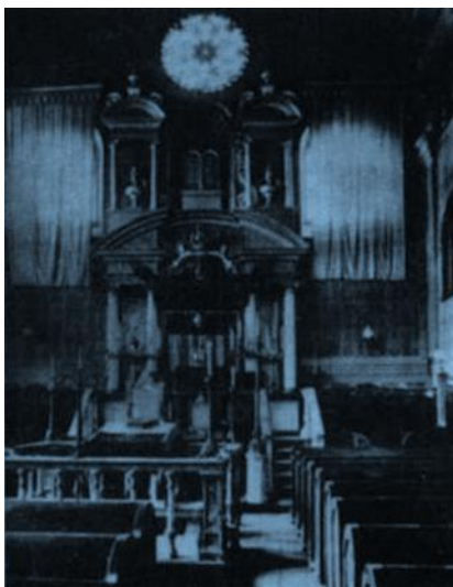
Interieur der Grosshofsynagoge, die bei der Assanierung am 20. Mai 1906 eingerissen wurde
