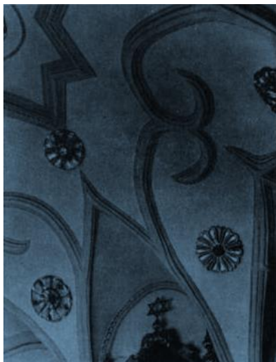
Hohe Synagoge; Stuckverzierungen des Gewölbes nach einer Restaurierung
