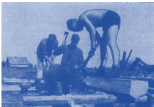
Pioniere richten Bunkerholz zu
