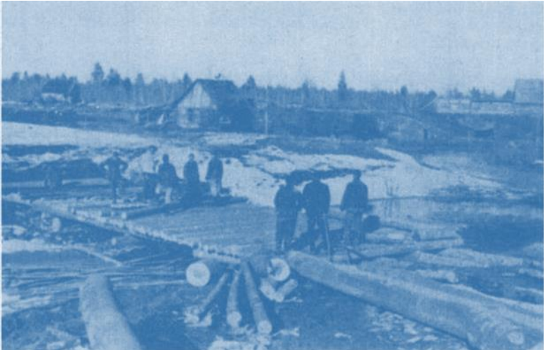
Brückenbau am Ljadno – Frühjahr 1942
