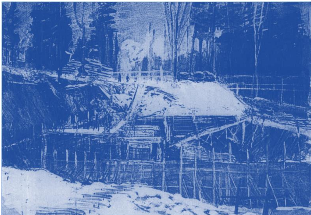
67 Führerhauptquartier «Riese». Errichtung des Führer-Bunkers in offener Bauweise. (Zeichnung des OT-Kriegsmalers Manninger)
