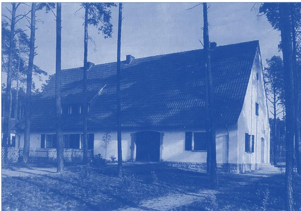
68 Führerhauptquartier «Maybach II». Ansicht eines der als Wohnhäuser getarnten Bunkergebäude
