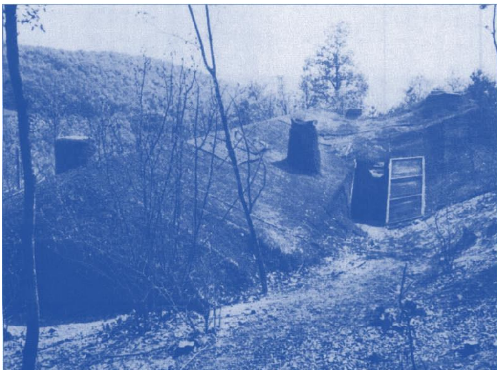
22 Führerhauptquartier «Felsenest». Arbeitsbaracke (links) und Bunker Hitlers (rechts)
