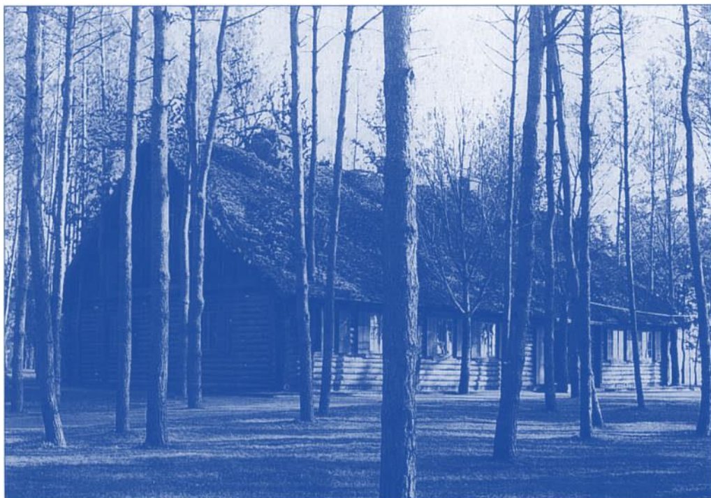
52 Führerhauptquartier «Eichenhain» («Wehrwolf») Aussenansicht einer der Blockhausbaracken
