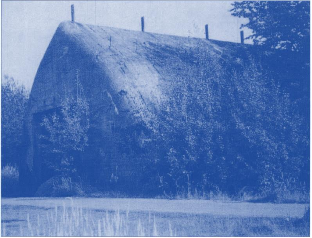
49 Führerhauptquartier «Askania Mitte». Der für die Aufstellung von Sonderzügen errichtete Schutzbau
