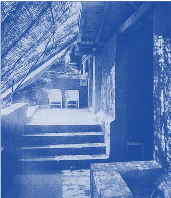
24 Führerhauptquartier «Felsenest». Terrasse und Zugang zu Hitlers Arbeitsbaracke, mit Tarnschutz versehen
