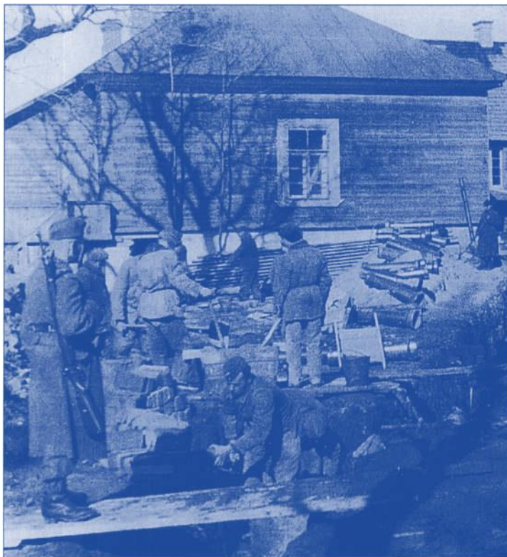
59 Führerhauptquartier «Wasserburg». Arbeiter der OT beim Her- richten des Hauptquartiers
