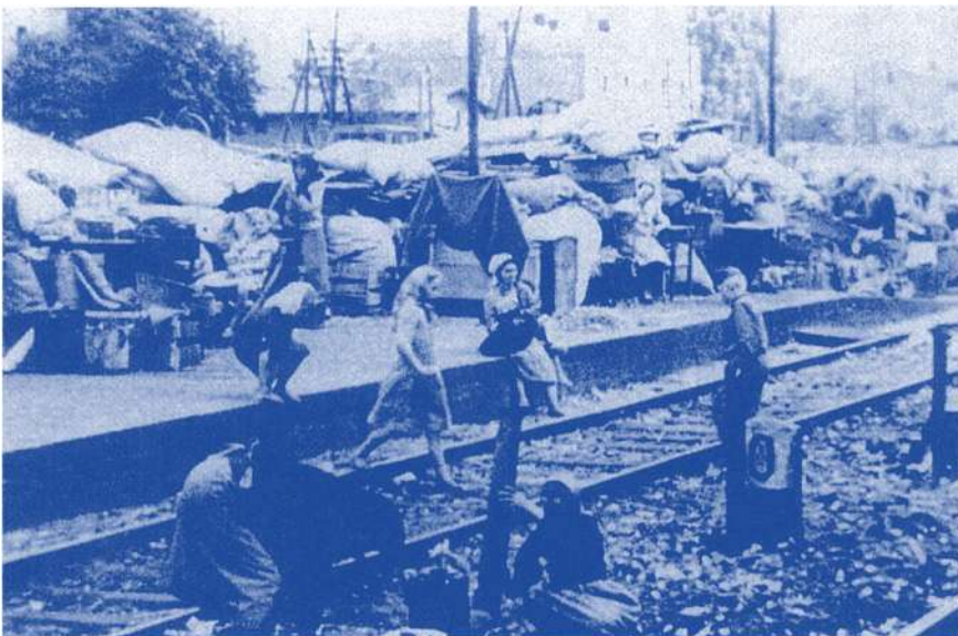
Der Mangel an Transportmitteln bedeutete für die Übersiedler häufig mehrtägiges Warten auf den Bahnhöfen. Polnische
