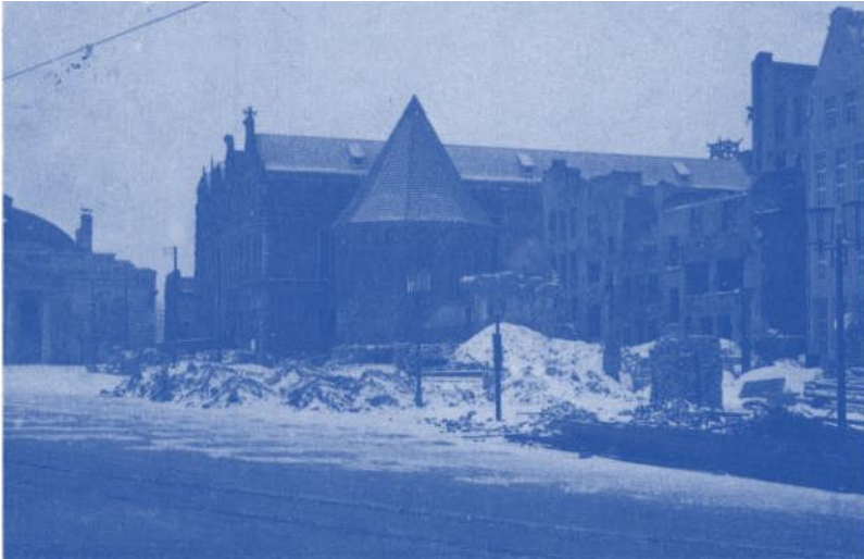
78 So sah der Theaterplatz mit dem Grossen Zeughaus (Zbrojownia) im Januar 1951 aus. Bei Kriegsende standen nur noch die vier Aussenmauern.
