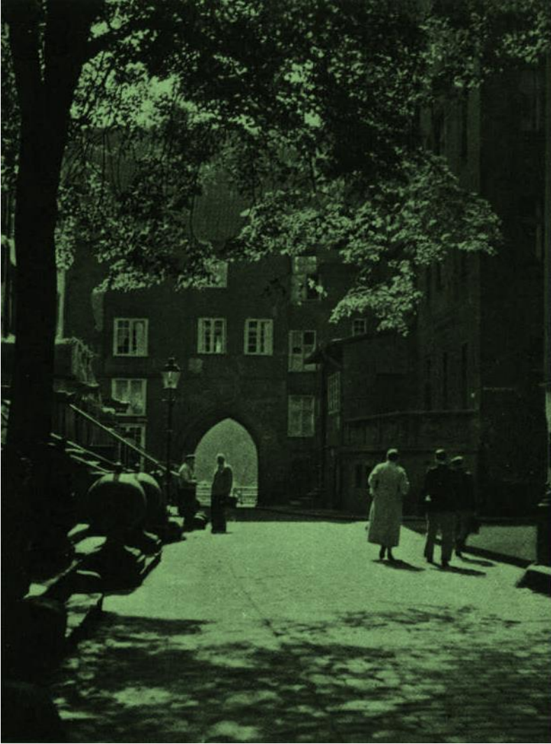
18 Sonne über der Frauengasse mit ihren Beischlägen und am Frauentor, das zur Mottlau hin abschliesst. Über dem gotischen Tordurchgang ein farbiges Stadtwappen. Rechts neben dem Tor das Gebäude der 1743 gegründeten Naturforschenden Gesellschaft.
