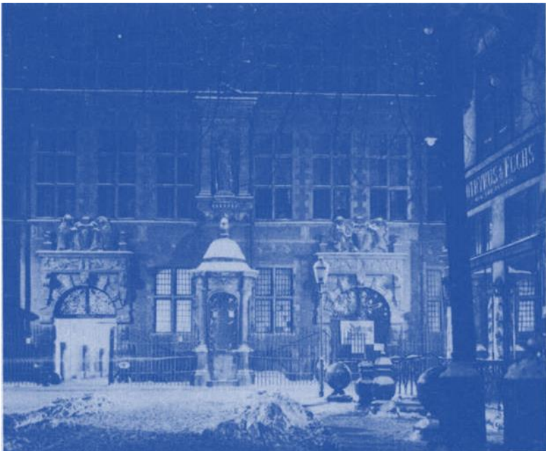
11 An einem Winterabend in der Jopengasse vor dem Grossen Zeughaus.
