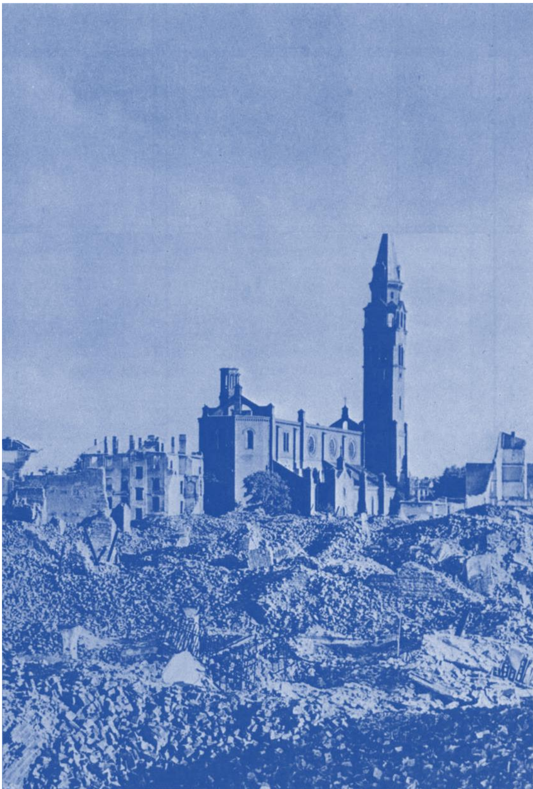
Die Warschauer Kapitulationsakte verlangt die restlose Räumung der Stadt. Am 4. Oktober 1944 beginnt der Auszug der Zivilbevölkerung, die 150'000 Tote beklagt. In Kanalisationsschächten und Ruinenkellern der ausgestorbenen Stadt verbergen sich Widerstandsgruppen und Einzelgänger, die den Kampf noch immer nicht aufgegeben haben.
