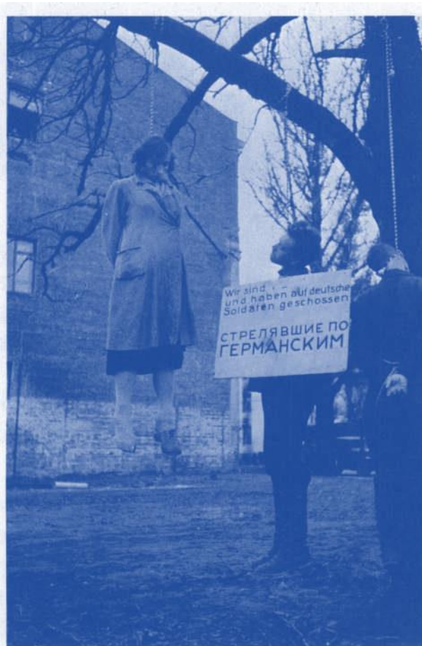
Gehenkte an Bäumen, Balkonen und Laternenpfählen: So soll die Bevölkerung der besetzten Gebiete von der Nutzlosigkeit des Widerstandes überzeugt werden. Hitler sucht die Schockwirkung des «fürchterlichen Todesschreckens».
