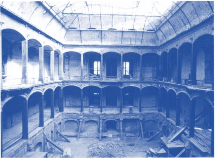
Ehemaliges Kunstgewerbemuseum, 1877-1881 von Martin Gropius und Heino Schmieden erbaut. Ansicht der Südfront. Der Lichtof während der Instandsetzungsarbeiten, 1980
