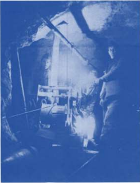
21. März 1940, Festungsbau, Stollen: «Bis Frühsommer das Schwergewicht in den Grenzzonen»
