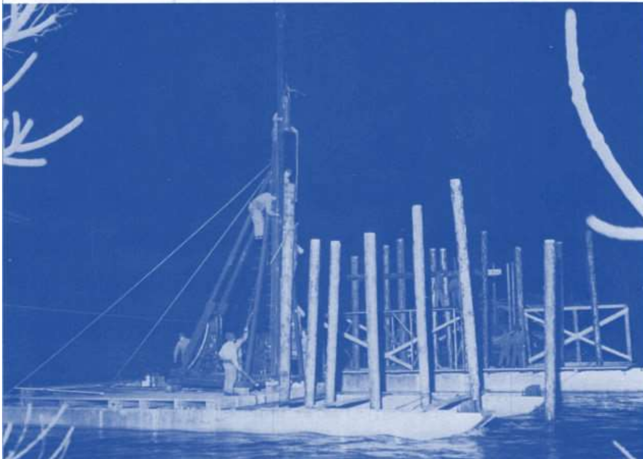
15. März 1941, Marfeldingen: Brückenbau bei Nacht
