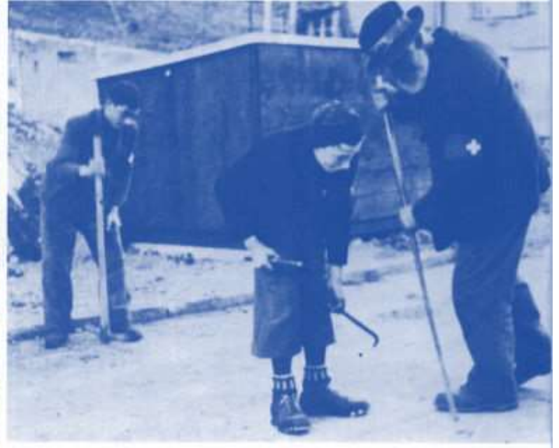
17. Februar 1941: Drei Generationen beim ersten Handanlegen an einem Strassenhindernis
