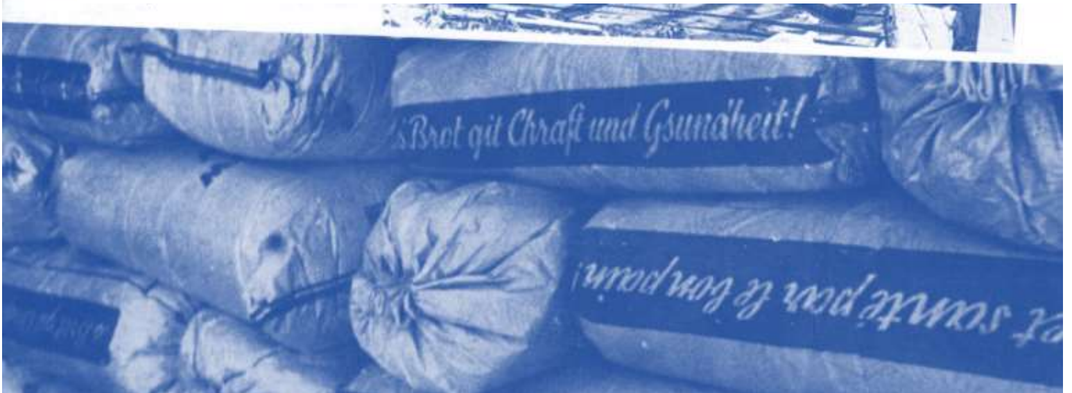
Mai 1941, Réduit: Kilometerlange Stollen mit Vorrat
