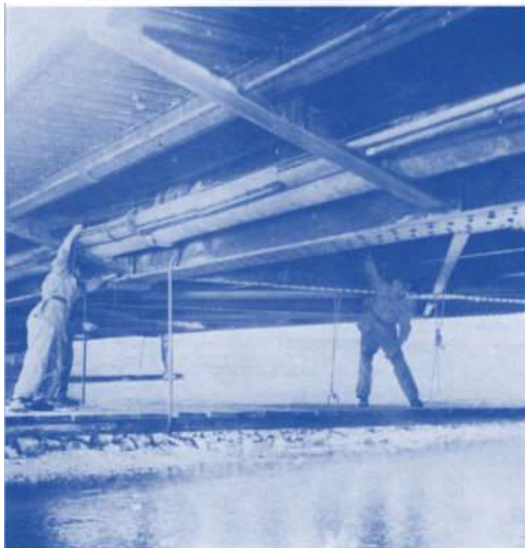
Unten rechts: 20. August 1940, Zerstörungstruppe legt Sprengkabel: Am Ende des Aktivdienstes ca. 26'000 Mann
