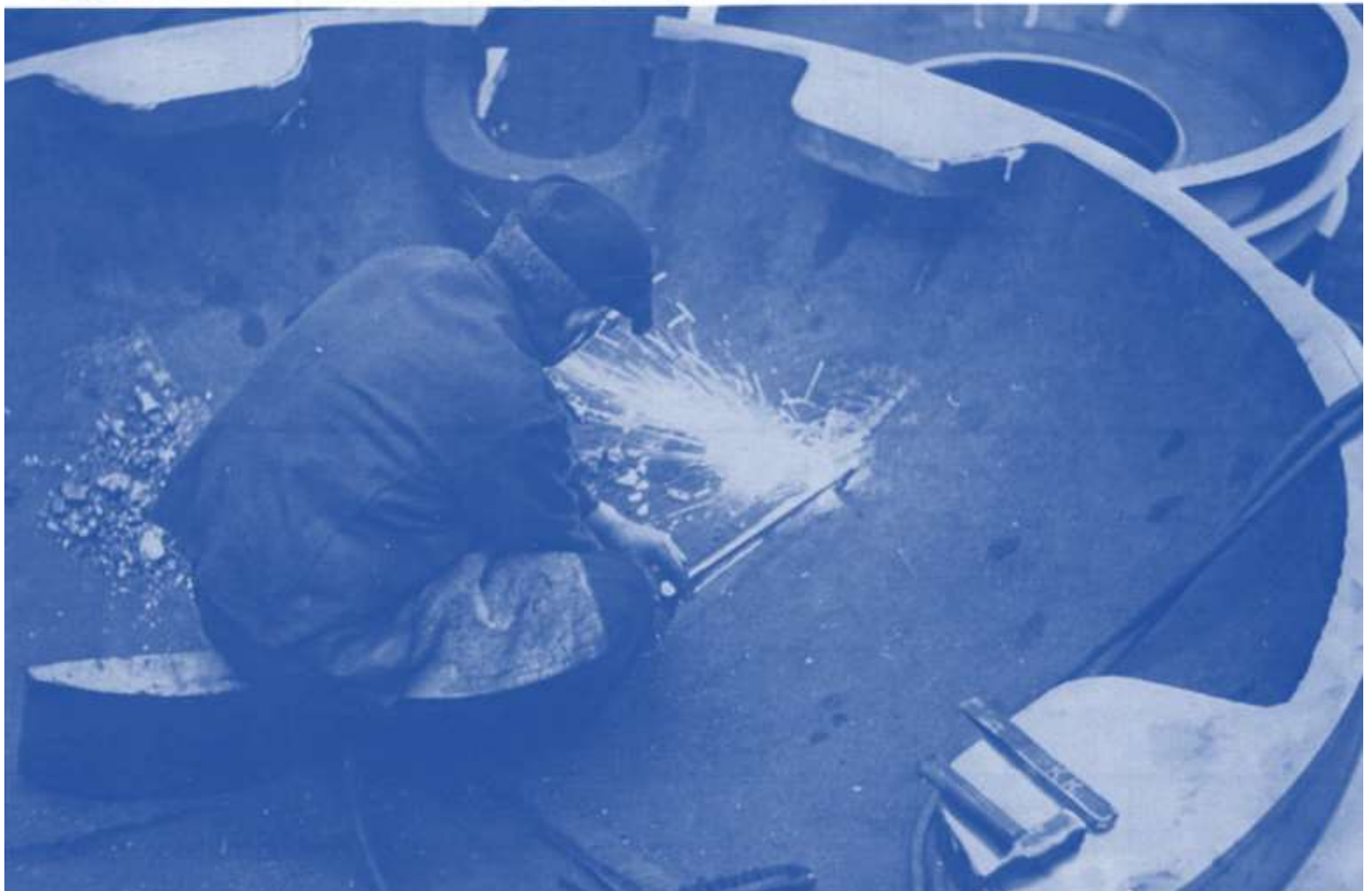
16. Mai 1941, Maschinenfabrik Oerlikon: Schweissarbeiten an den Panzerkuppeln
