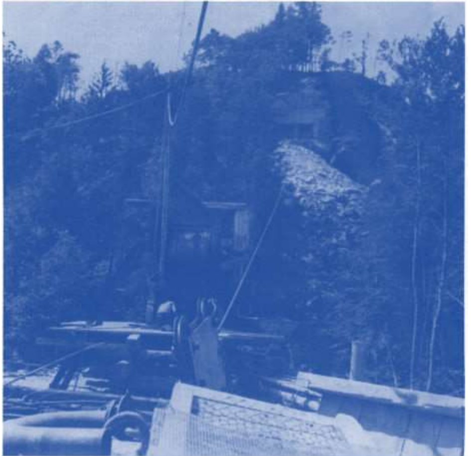
30. September 1940. Grenzraum Nähe Brugg, Bunkerbau: «Vornehmlich taktische Bedeutung»
