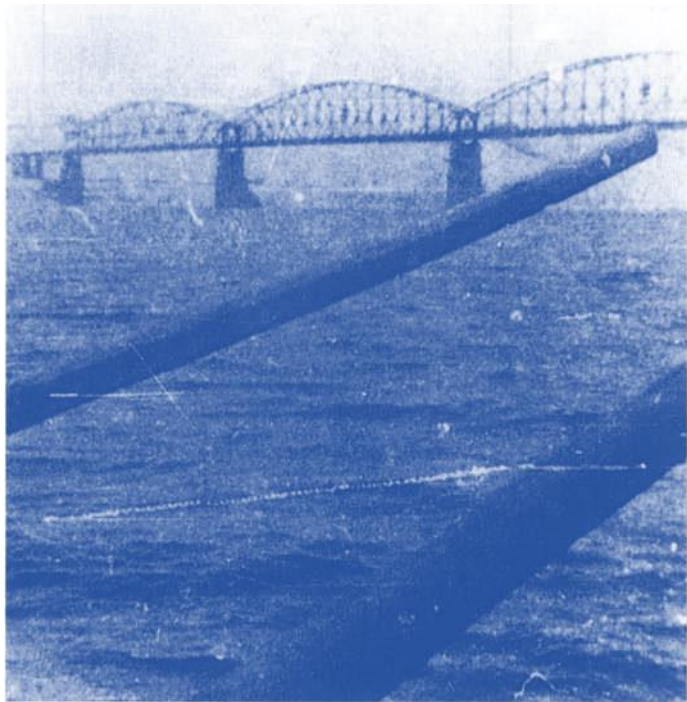
Die Brücke über die Wolga bei Kasan.
