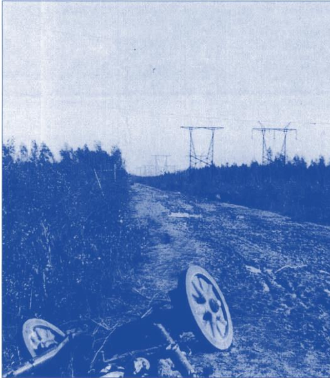
22 Die «Elektro-Schneise» an der Nordostflanke des Flaschenhalses. Hier scheiterte der erste Versuch der Rotarmisten, mit einem Stoss zur Newa die Landverbindung nach Leningrad herzustellen.
