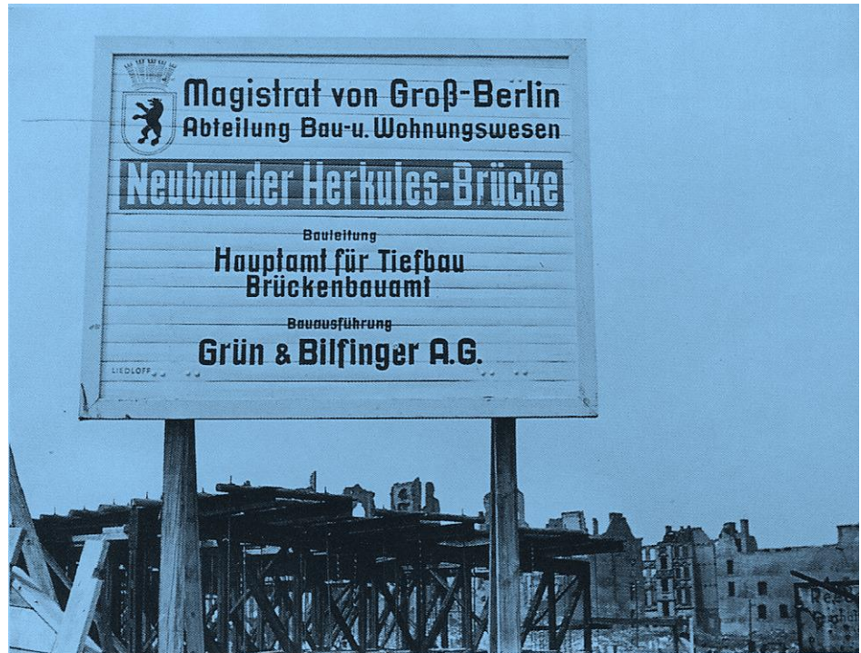
Neubau der über den Landwehrkanal führenden Herkulesbrücke im Bezirk Tiergarten, 1950.
