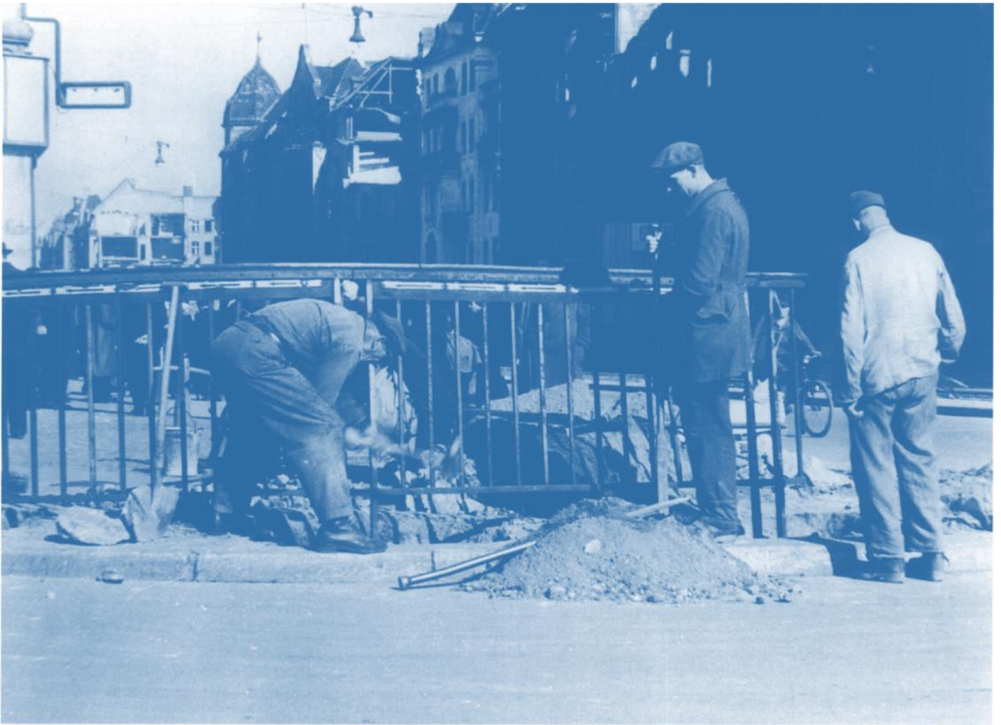
Instandsetzung der Bürgersteige am Neuköllner Hermannplatz, 1949.
