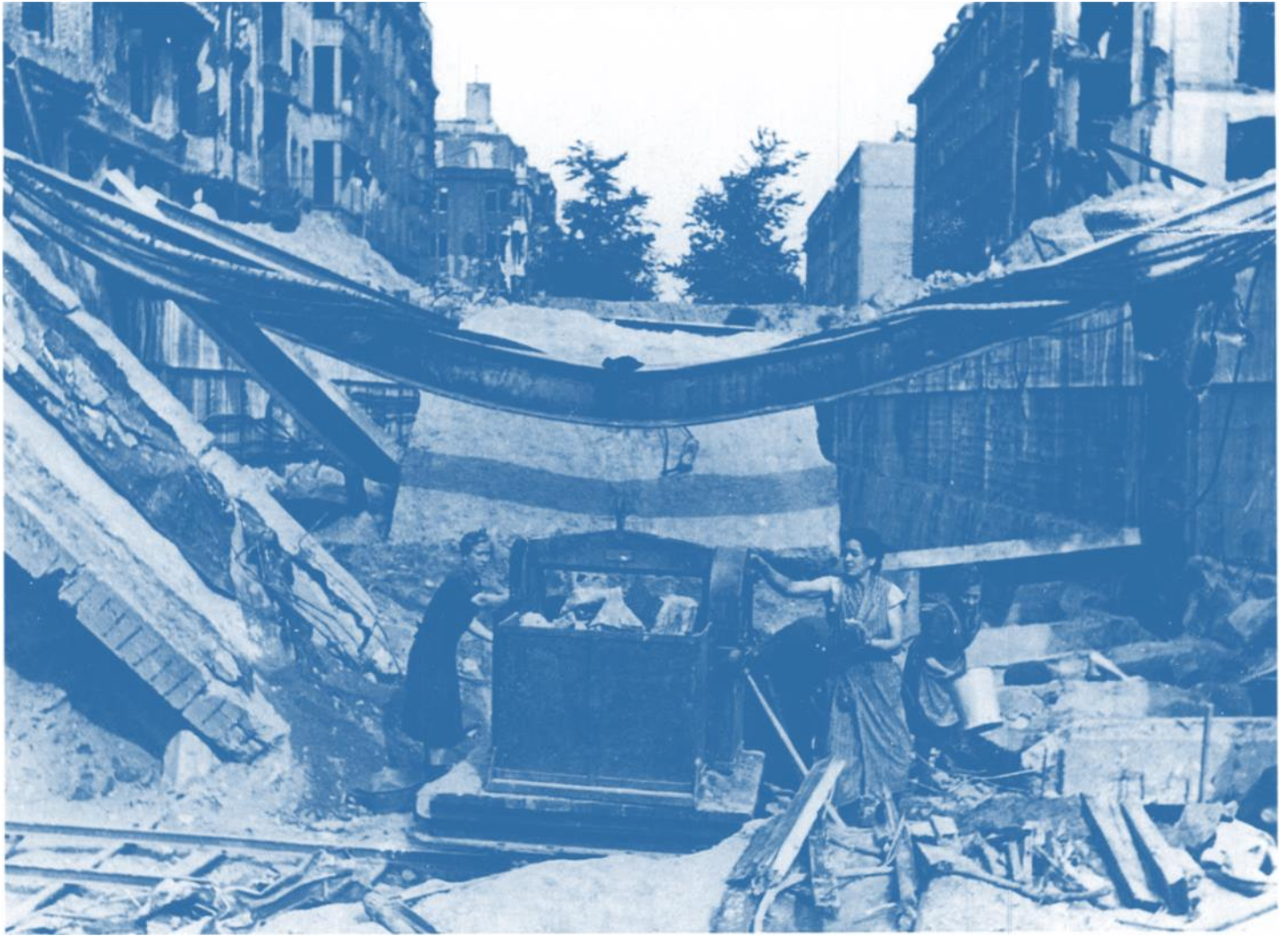
Aufräumungsarbeiten im U-Bahnhof-tunnel in der Innsbrucker Strasse in Schöneberg, 1946.
