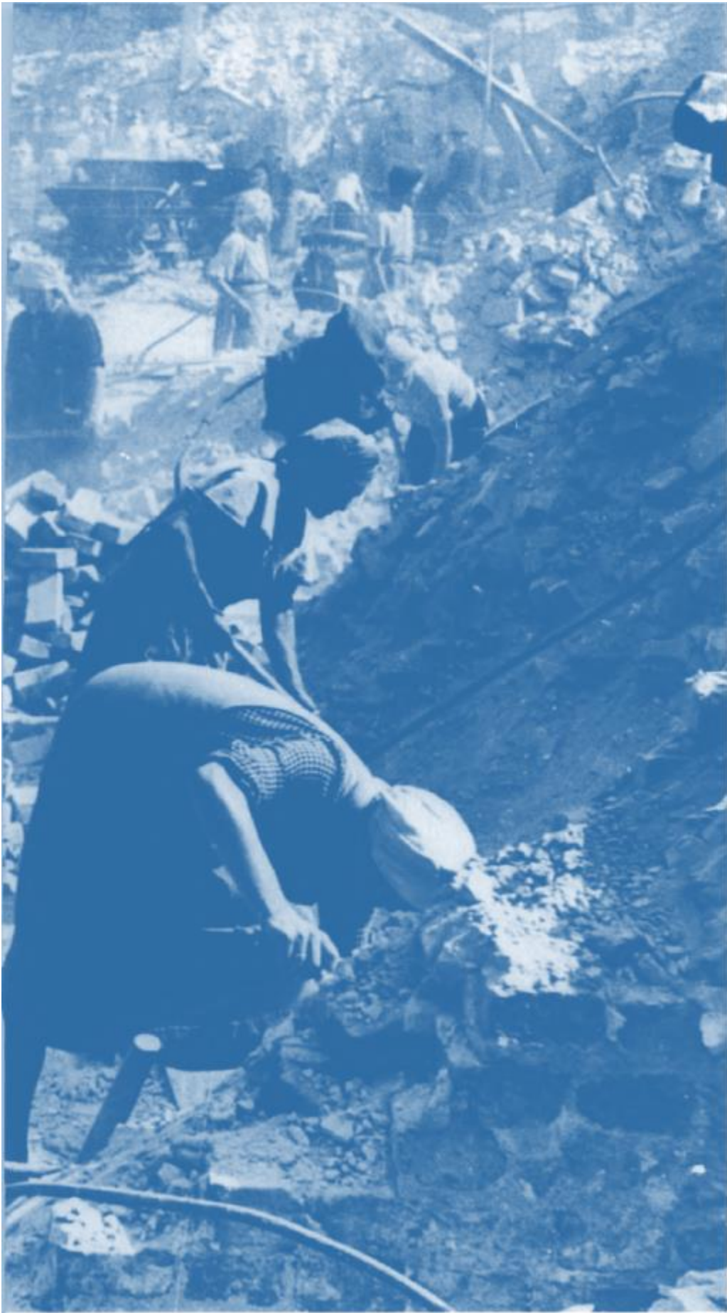
Aufräumungsarbeiten in der Behrensstrasse, 1947.
