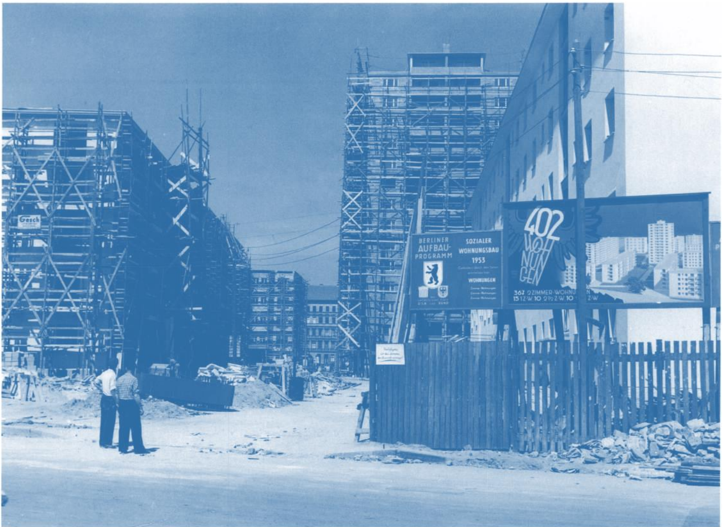
Im Rahmen des Berliner Aufbau-Programms entsteht die Ernst-Reuter-Siedlung (Ackerstrasse 132-133) im Wedding, 1954.
