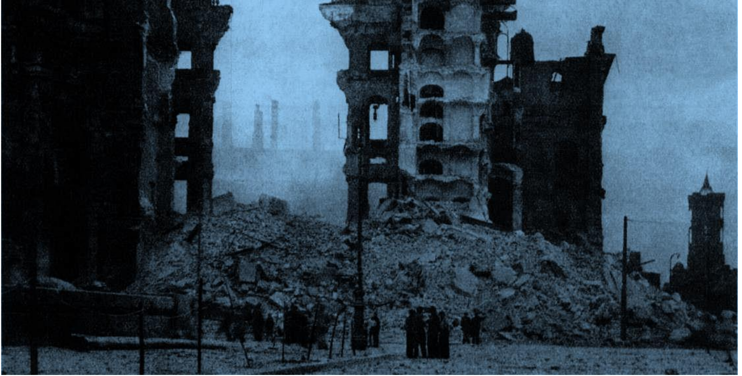
Sprengungsarbeiten an der Südseite des Stadtschlosses in Berlin-Mitte, 1950.
