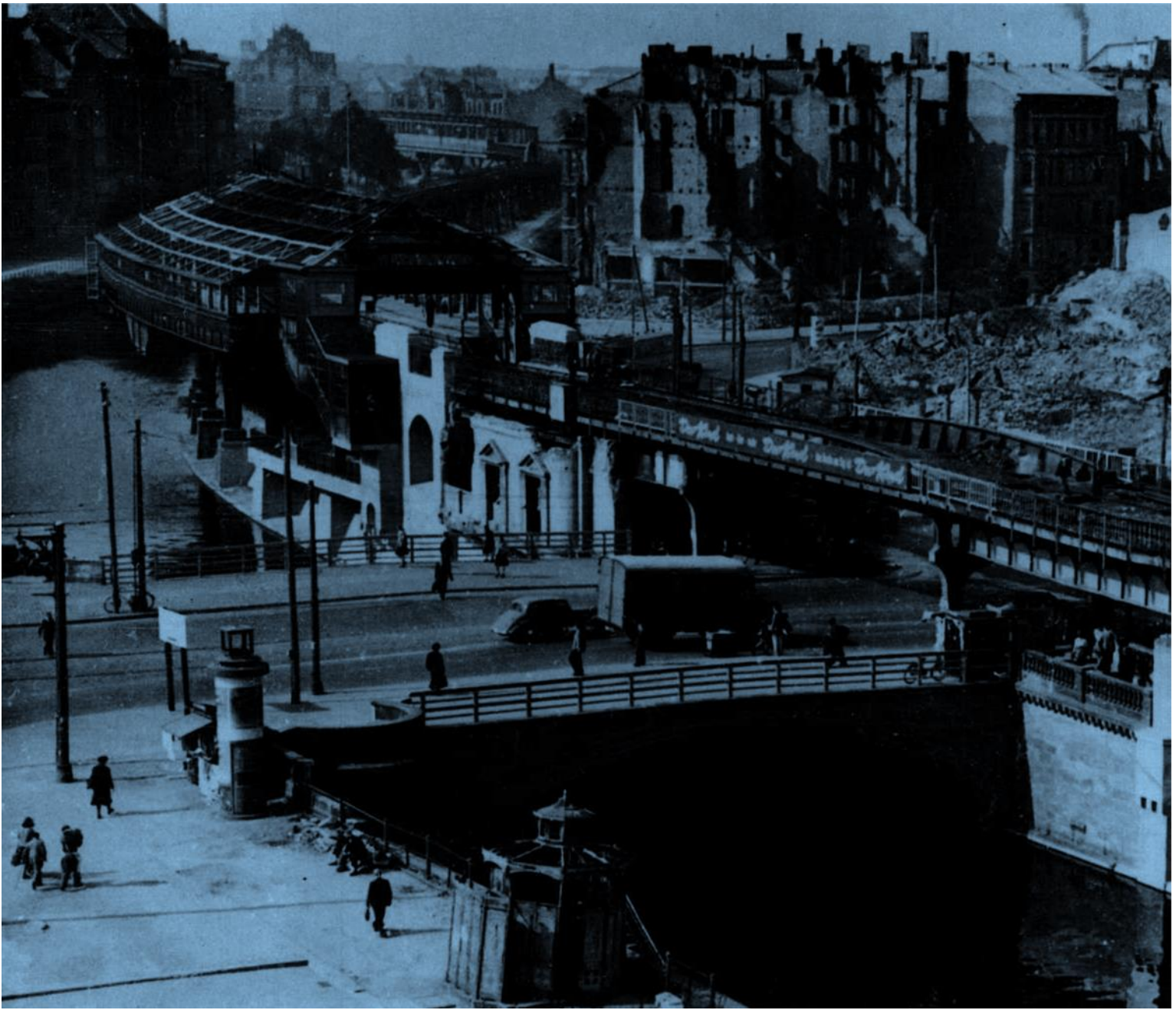
Der stark beschädigte Hochbahnhof Halle- sches Tor mit den Trümmern des Belle- Alliance-Platzes (heute Mehringplatz) im Hintergrund, 1948.
