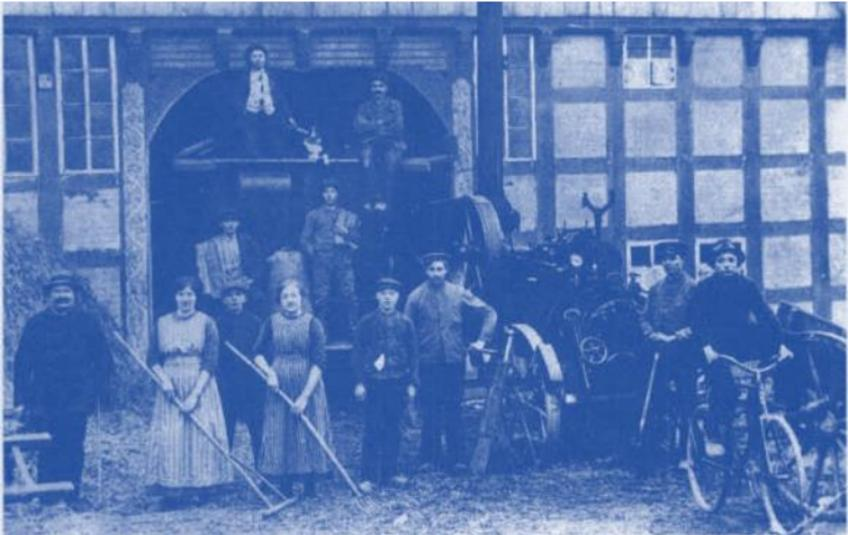
*Bis Mitte der Zwanziger Jahre wurde auf den Höfen noch mit der Lokomobile, einer fahrbaren Dampfmaschine, gedroschen. Das Foto vom Hof Haselhorst in Rotenhagen bei Werther stammt aus dem Jahr 1910.*
