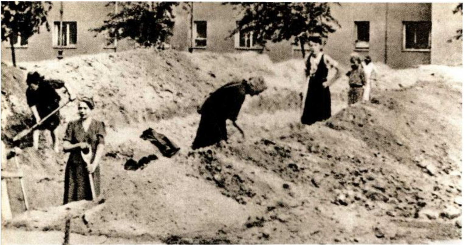
Die weiblichen Bewohner helfen den AK-Einheiten beim Ausschachten von Verbindungsgräben
