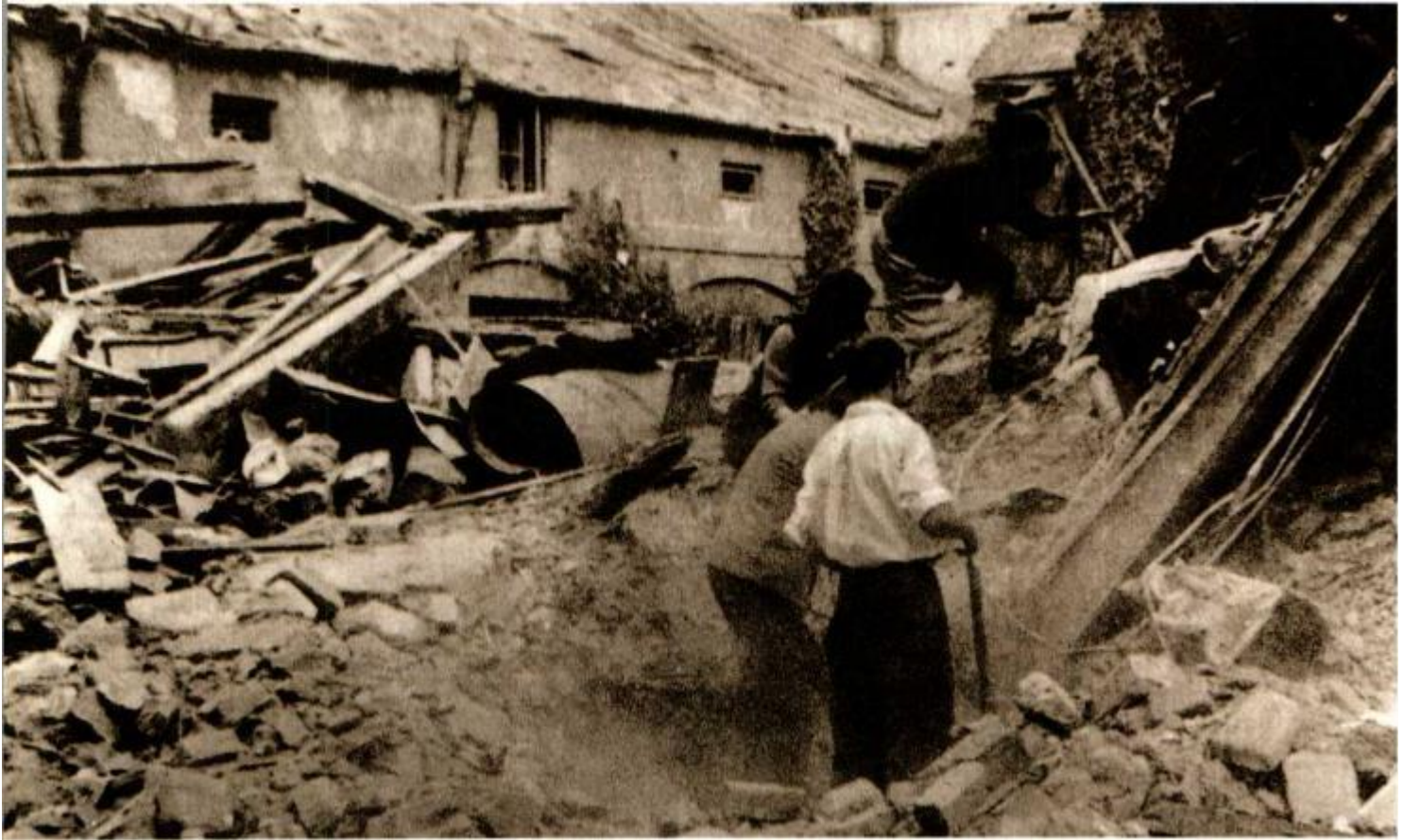
Ein durch einen Stuka-Angriff völlig zerstörtes Haus: Suche nach Überlebenden
