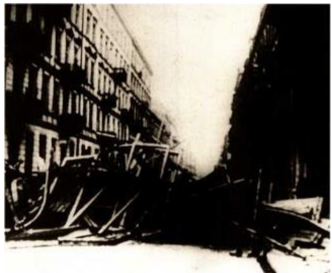
Diese Barrikade sperrt die Zufahrt zu einer Strasse in der Altstadt
