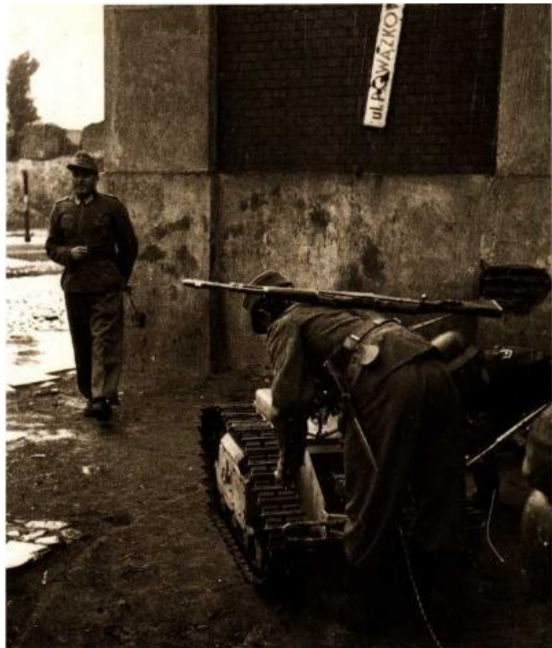
Hinter einer Hauswand bereiten deutsche Soldaten einen Sprengpanzer «Goliath» für den Einsatz vor
