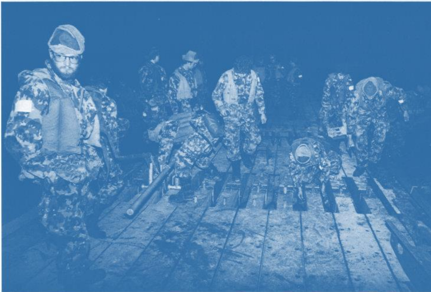
50-Tonnen-Brücke im Bau.
