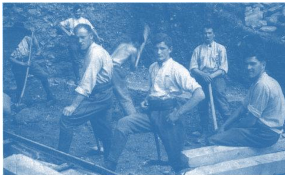
1940: Stellungsbau in der Armeestellung. F Btrr 68 bei Wohlen (AG).
