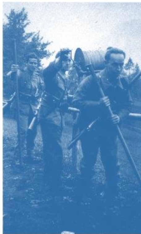
1940. Kabelbau im Felde.
