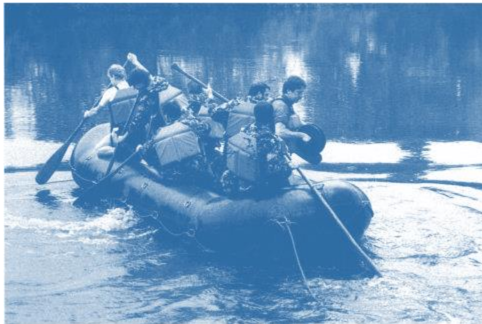
1984 bei Hägendorf. Gren Kp 20 beim Stegbau.
