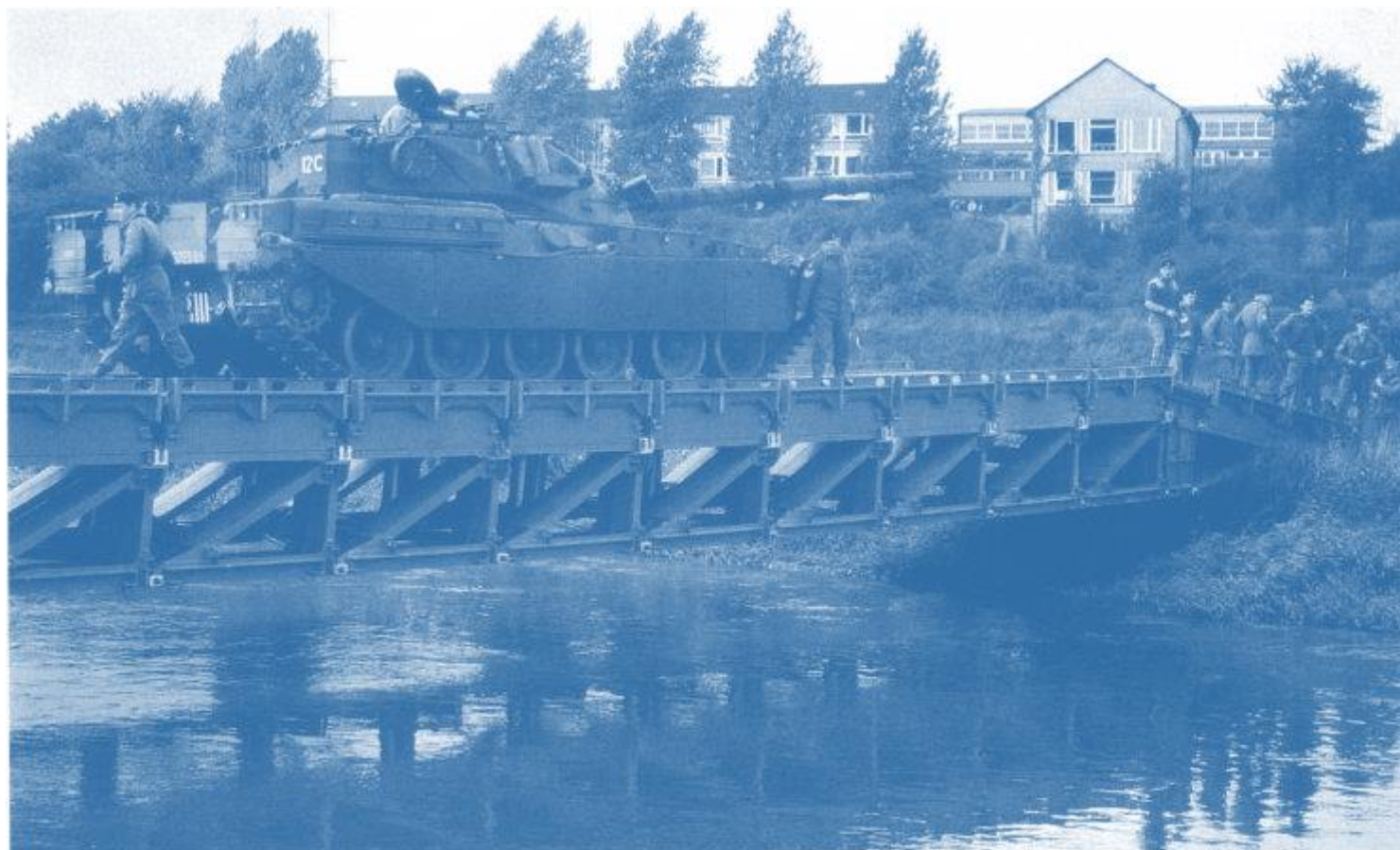
Panzer auf 50-Tonnen-Brücke (Test des neuen englischen Brückenmaterials in England).
