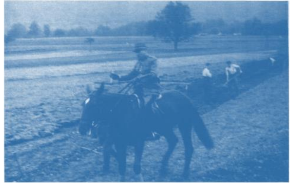
Limmat-Stellung 1939. 1. Reko im Gelände. Beginn der Bauarbeit.
