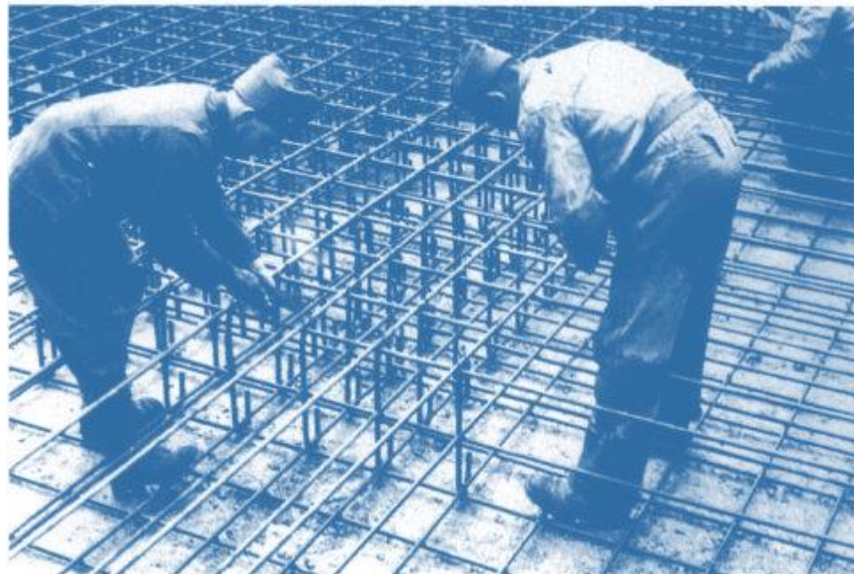
Limmat-Stellung. IV/44 beim Bunkerbau.
