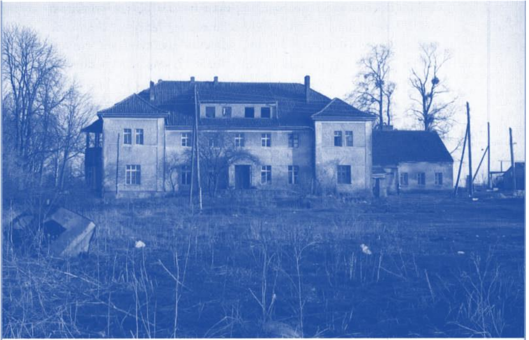
Das Gutshaus in Samonien/Reiterhof heute: In Wolfgang Rothes Elternhaus wohnen noch zwei russlanddeutsche Familien, der Rest des Gebäudes steht leer und verfällt. Vom ehemaligen Vierseitenhof sind nur vereinzelte Stallruinen übrig.
