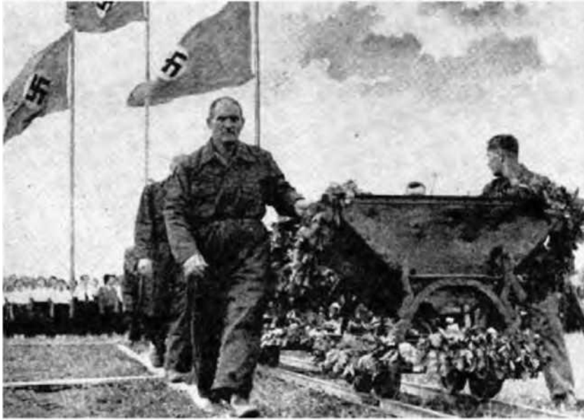
Abb. 27: «Kaum hat Gauleiter Globocnik seine Rede beim Spatenstich zur Holzwebersiedlung beendet, schreiten die Bauarbeiter zur Tat»
