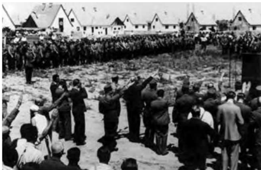
Abb. 23: SA-Formationen vor den fertiggestellten Siedlungshäusern.
