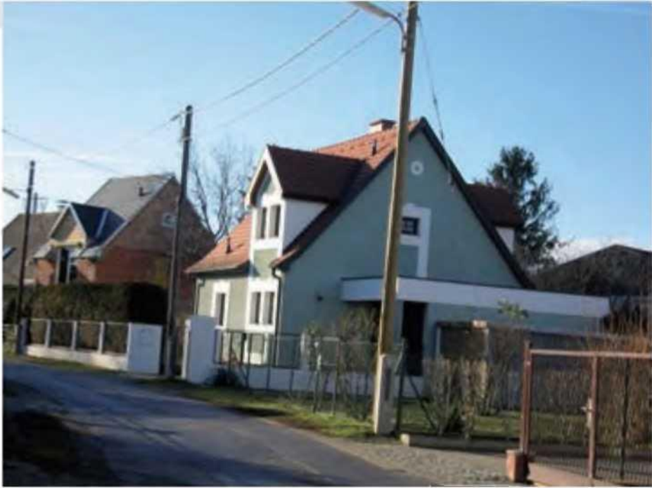
Dok. 81: Zum Teil heftige Um- und Zubauten bemühen sich, die ursprünglichen Kriegsopfer-Siedlungshäuser dem heute in der Siedlung vorherrschenden Einfamilienhauscharakter anzugleichen.
