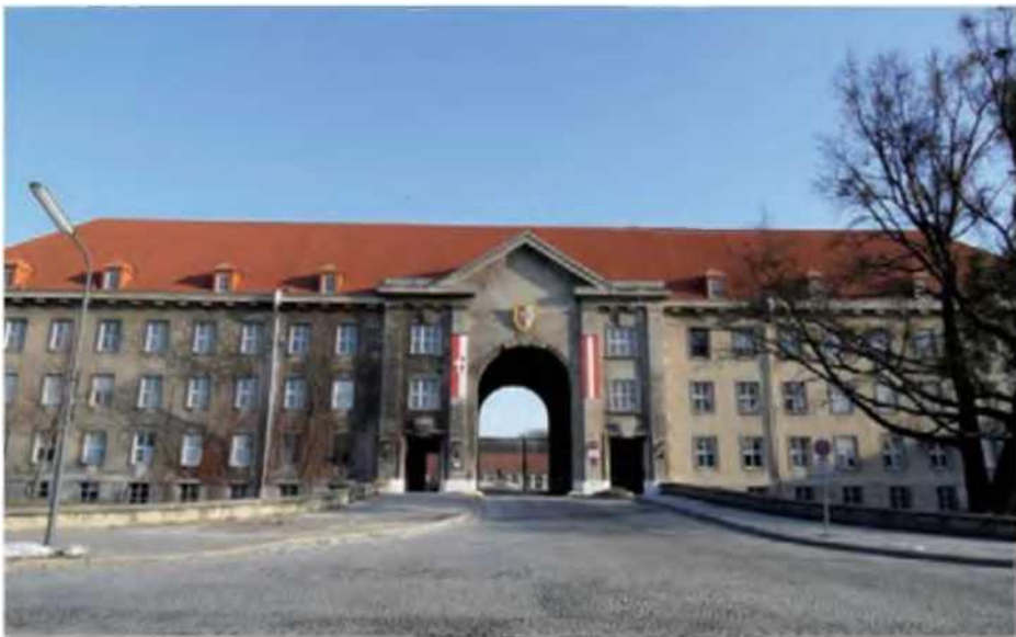
Dok. 138: Portal der Fasangartenkaserne.
