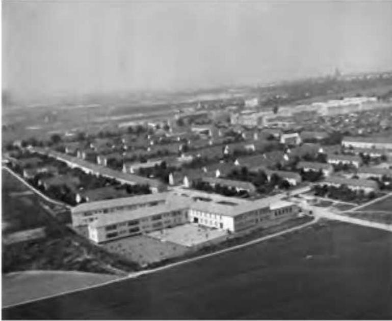
Dok. 105: Siedlung Wienerfeld Ost, Aufnahme SO nach NW, 1956.
