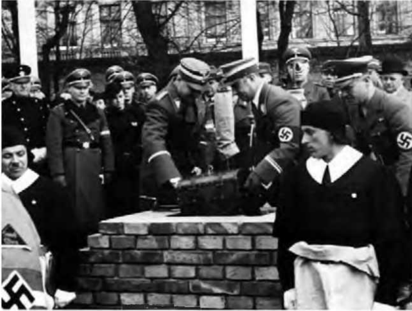
Abb. 35: Spatenstich im Augarten für das von Berlin gestiftete HJ-Heim.
