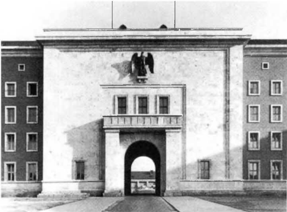
Dok. 137: Portal der SS-Kaserne Nürnberg.
