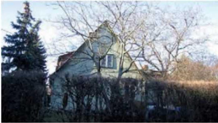
Dok. 65: Wenige Originalhäuser sind hinter Zäunen erahnbar. Ecke Oberhummergasse/Oswald Redlich-Gasse. Doppelhaus, Seitenfassade Ost.
