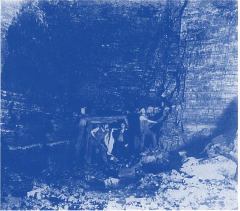
Abbau von Kohle in einem Kohledom, die Mächtigkeit der Flöze betrug bis zu 10 Meter.
