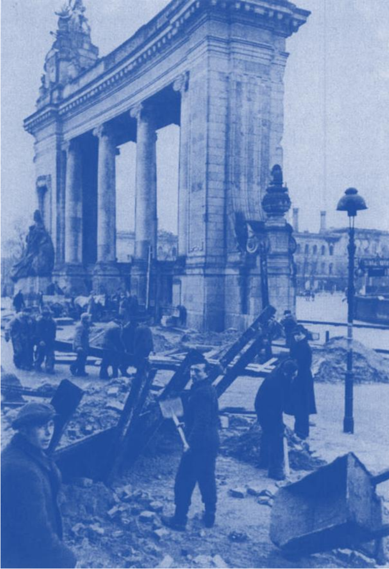
31 Bau einer Panzersperre an der Charlottenburger Brücke. März 1945.
