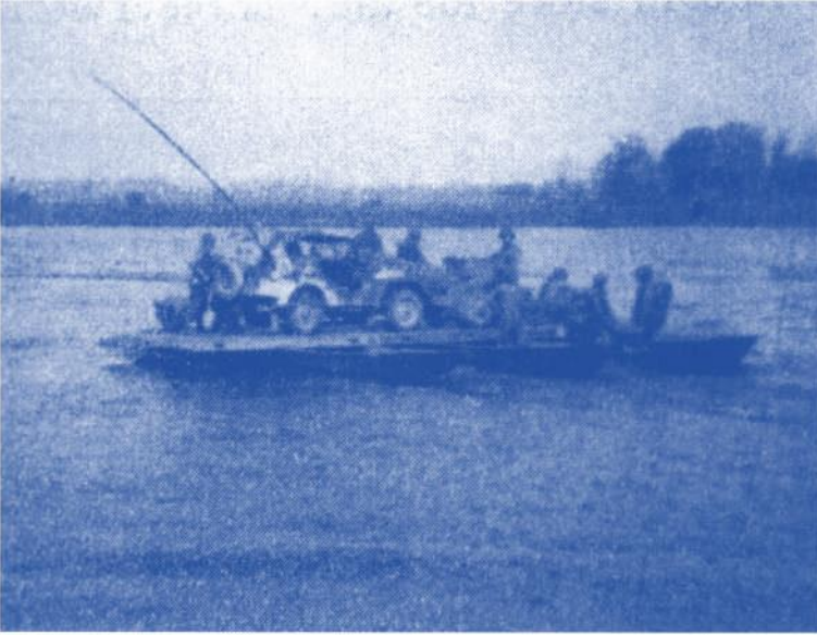
Mit schnell zusammengebauten Fähren geht es über die Elbe
