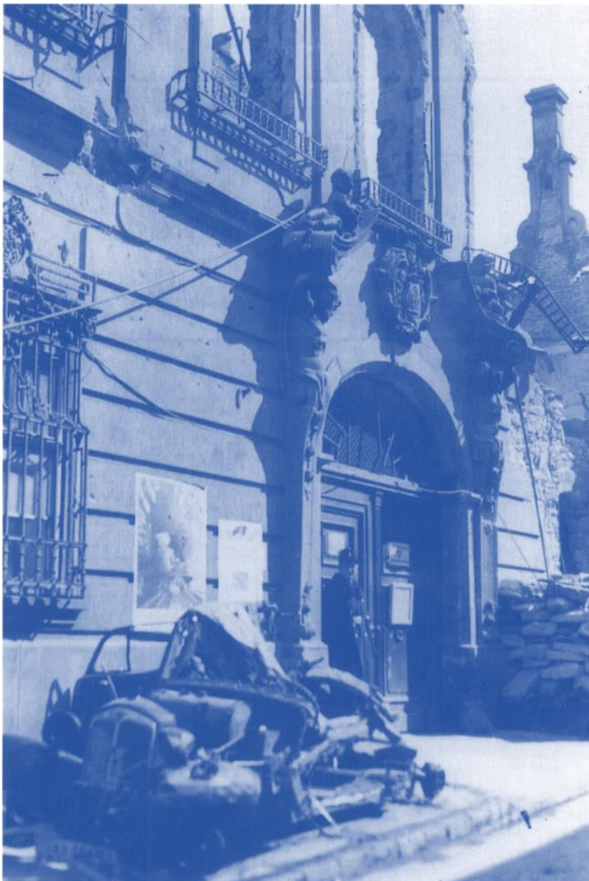
Zerstörte ehemalige britische Gesandtschaft an der Verböcsy utca (ETH/Archiv für Zeitgeschichte)
