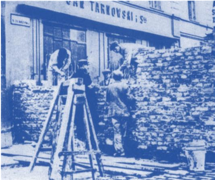
7. Bau der Gettomauer
