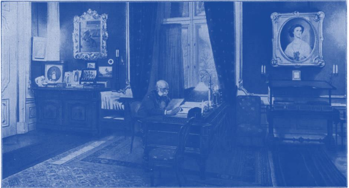
Kaiser Franz Joseph in seinem Arbeitszimmer Nach einem Bilde von Matsch
