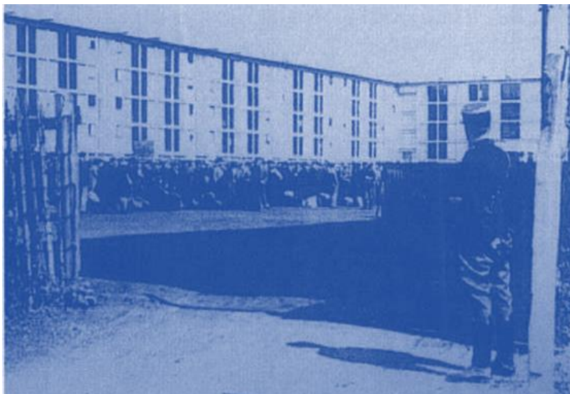
Das Internierungslager Drancy
