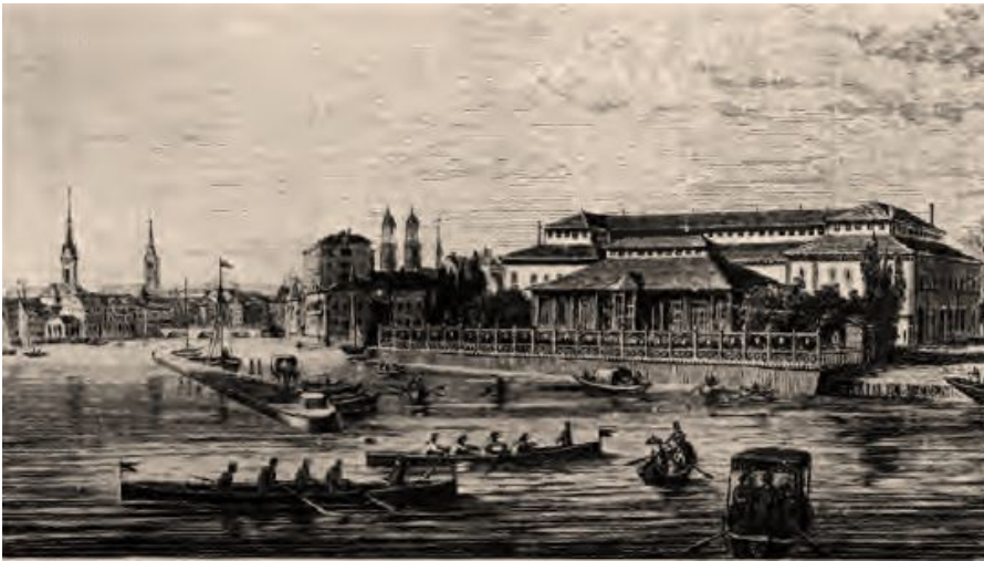
Die alte «Tonhalle» in Zürich, Schauplatz der gestörten Reichsgründungsfeier vom 9. März 1871.
