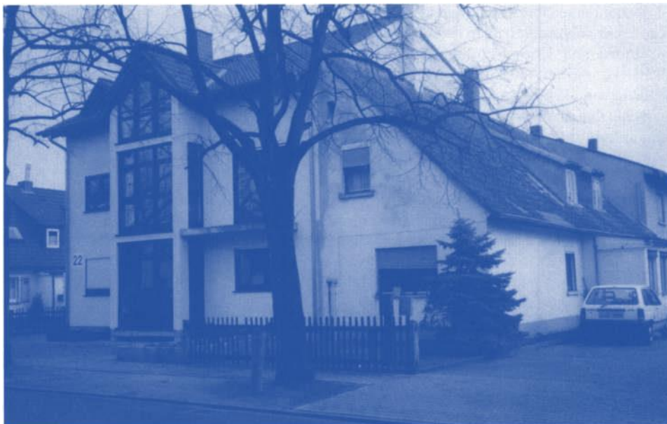
Abb. 32: Donauschwäbisches Doppel-Siedlerhaus in St. Stephan in «Streckform», linke Hälfte modernisiert
