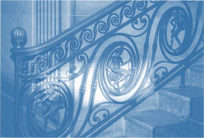
Detail des fein ausgearbeiteten Treppengeländers aus Bronze.
