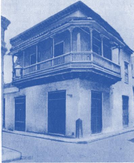
Das Haus in Havanna
