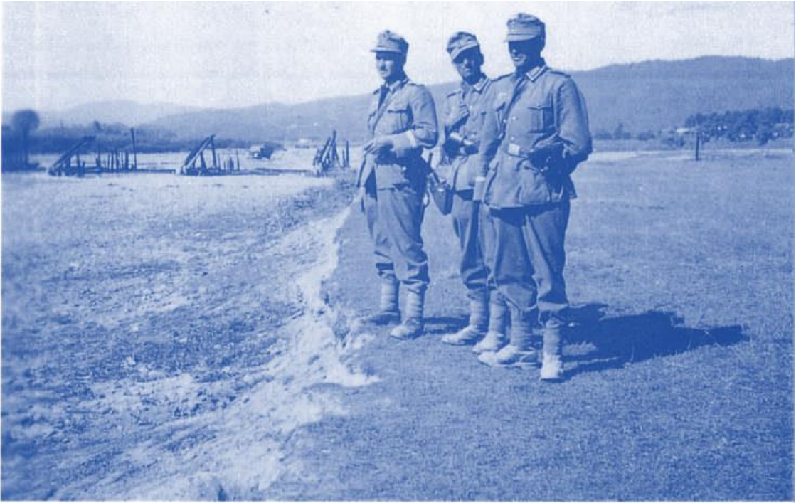
Diets Gebirgsjäger vor der zerstörten Brücke am Sanübergang bei Sanok (21)
