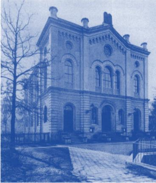
Die Linzer Synagoge wurde 1877 feierlich eröffnet; in der «Reichskristallnacht» brannte sie am 10. November 1938 bis auf die Grundmauern aus
