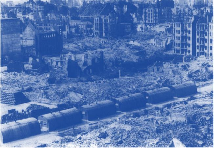
11 Die Wohnsituation in den zerstörten Städten war katastrophal. Wie hier in Hamburg wurden vielerorts Lager aus sogenannten Nissenhütten als Notunterkunft errichtet.
