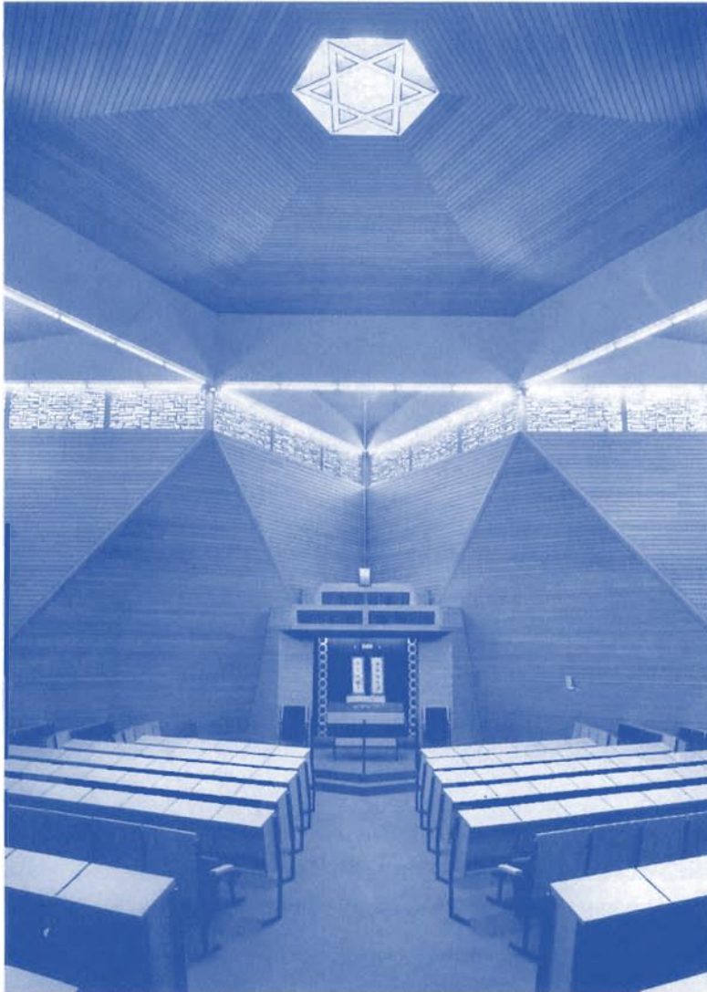
Der Davidstern als Grundriss: Blick in den Innenraum der von den Karlsruher Architekten Dr.-Ing. Hans Backhaus und Dr.-Ing. Harro Wolf Brosinsky an der Knielinger Allee erbauten neuen Karlsruher Synagoge
