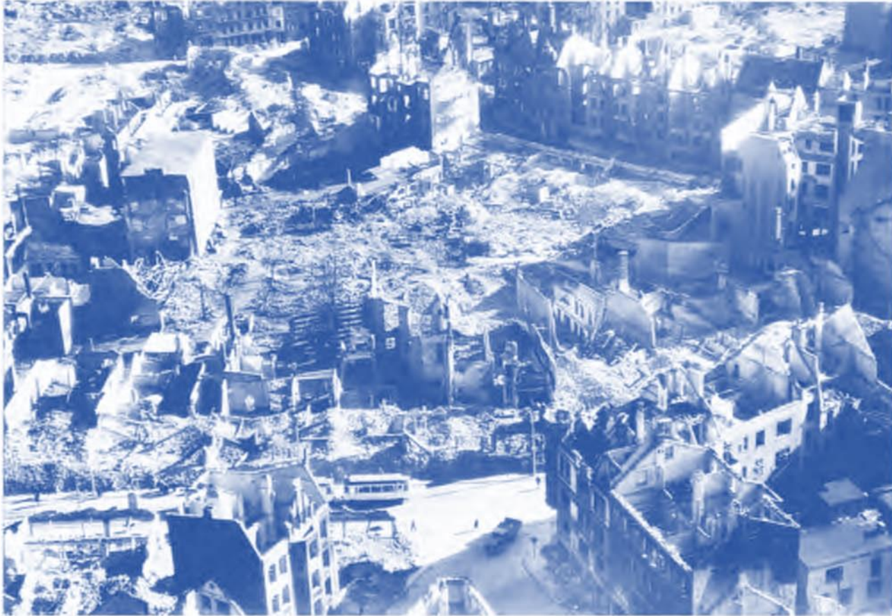
Trümmerwüste rund um die Kreuzung Holtenauer Strasse/ Lehmberg/ Mittelstrasse. Die Fahrbahnen werden nach den Angriffen zügig geräumt und die Verkehrseinrichtungen (Strassenbahn) schnell repariert. (RLMin.. Sept. 1944)
