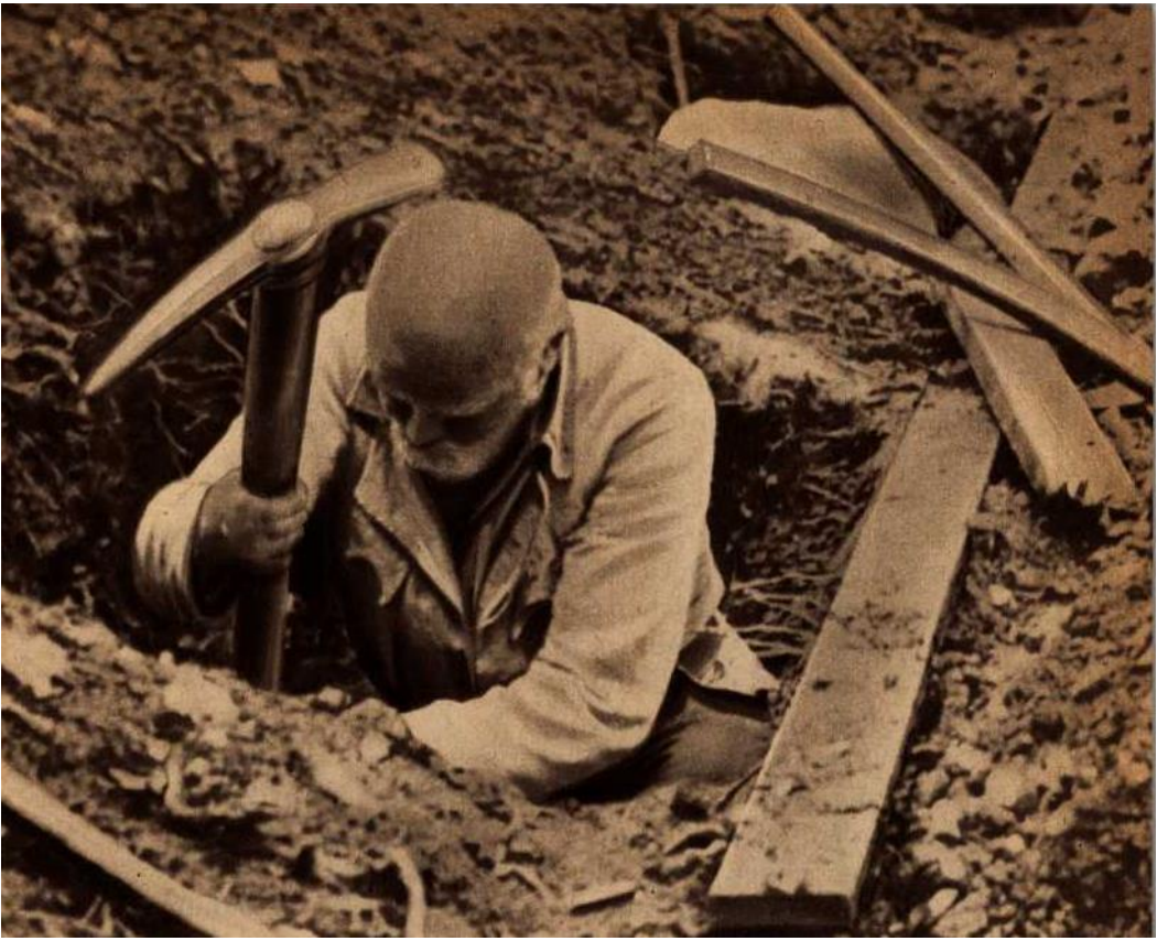
Ein Mann, der überall zupackt: Körner beim Bau der Cobenzl-Schisprungschanze
