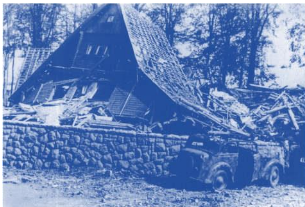
Abbildung 198: Zerstörtes Haus in der SS-Führersiedlung I, 24.8.1944 Quelle: F.N.D.I.R.P., Paris
