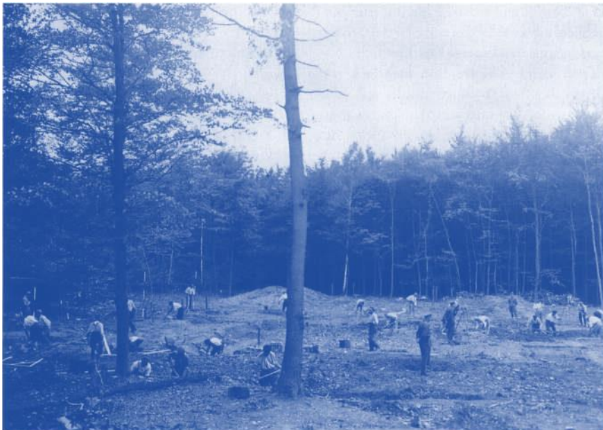
Abbildung 17: Text zum Foto: «Bild 19. Betrifft: Aufnahme im Konzentrationslager im Ettersberg. Das Lichtbild zeigt Schutzhaftgefangene bei Vermessungs- und Ausschachtungsarbeiten zum Bau neuer Baracken. Aufgenommen am 23. Juli 1937.»
