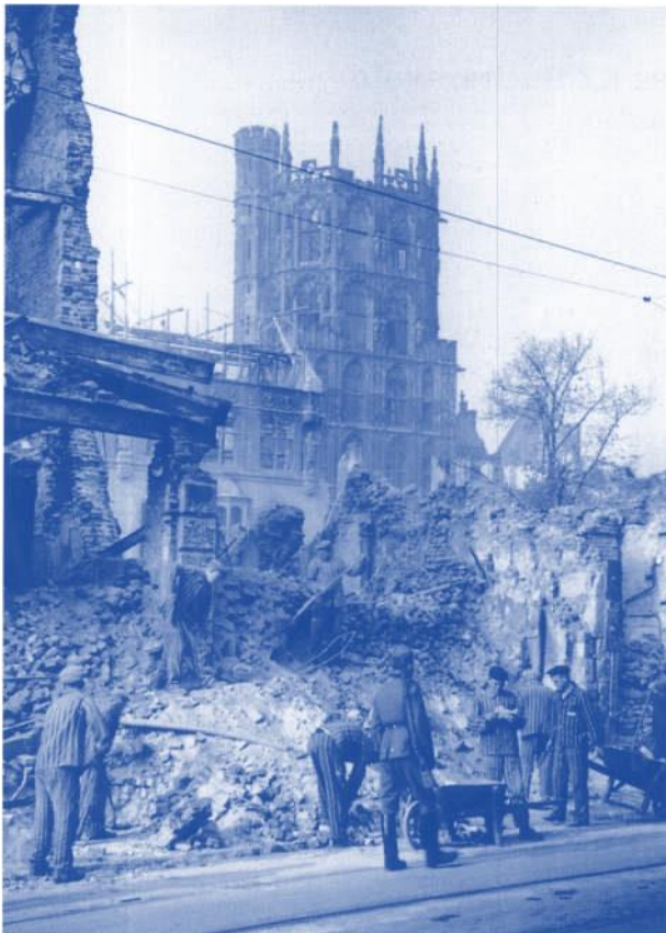
Abbildung 163: Häftlinge der SS-Baubrigade III bei der Trümmerbeseitigung in Köln, 23.10.1943 Quelle: Hist. Archiv Stadt Köln, Nachlass Peter Fischer F 400/17
