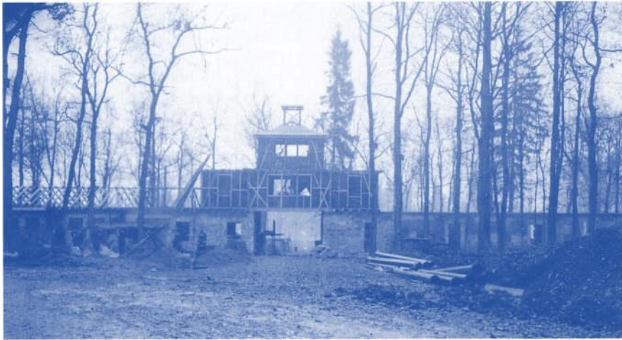
Abbildung 19: Text zum Foto: «Betr. Aufnahme im K.-Lager Buchenwald. Bild 46. Das Lichtbild zeigt das im Bau befindliche Eingangsgebäude zum Häftlingslager. Aufgenommen am 10.11.1937.»
