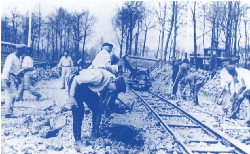
Abbildung 83: Bau der Strasse im Kommandanturbereich zum Haupttorgebäude (Carachoweg), Frühjahr 1938 (SS-Foto) Quelle: Sammlung Gedenkstätte Buchenwald, Weimar
