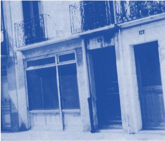
Das Haus der Ventajous mit dem Balkon der Fittkos direkt über dem Eingang zum Zollamt (Aufnahme von 1973).
