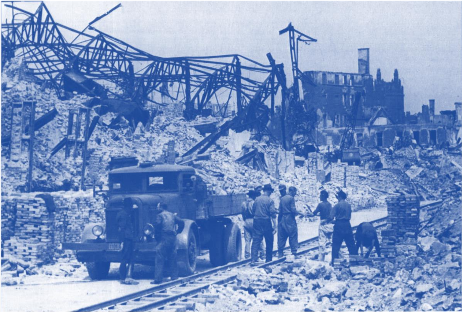
40 Danach. Aufräumungsarbeiten in der Sonnenstrasse.
