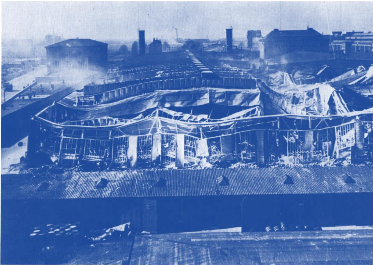
29 Nach einem Luftangriff am 9. Oktober 1943 auf das BMW-Werk wurde ein Teil einer Halle zerstört – einen anderen Teil der Halle konnte die Feuerwehr retten.
