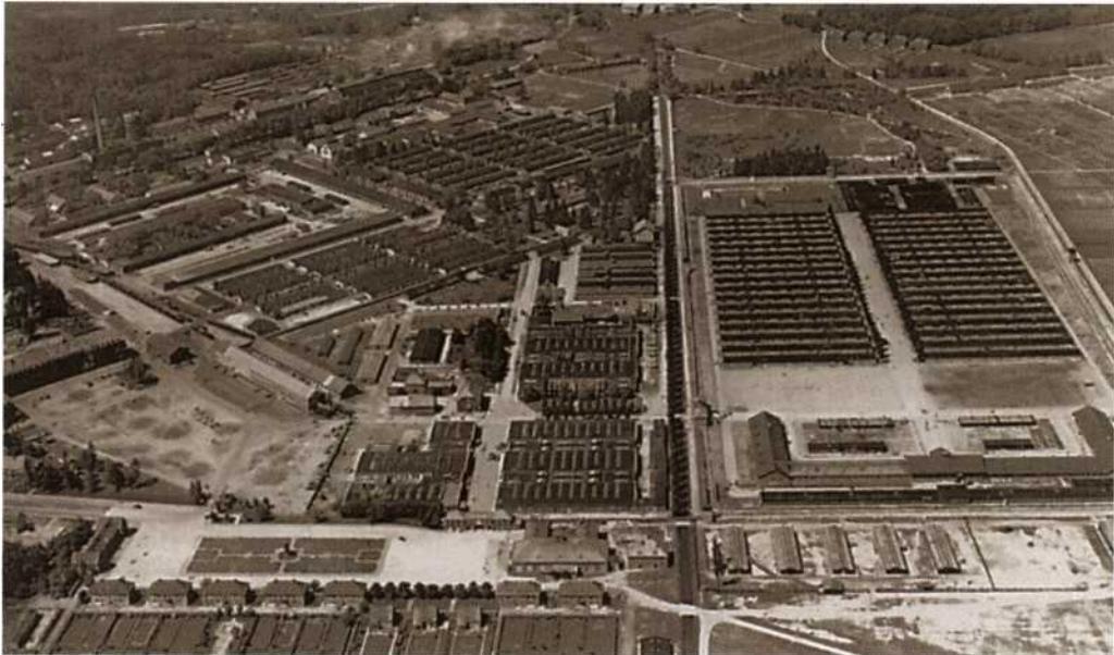
Das Schutzhaftlager des KL Dachau (rechts) mit dem angrenzenden gewaltigen Komplex des SS-Lagers. (Die Luftaufnahme entstand am 27. Mai 1945.)
