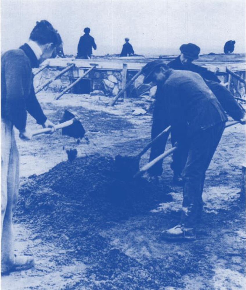
60 Hausbau in gemeinsamer Selbsthilfe. Neubürger beim Mörtelmischen.
