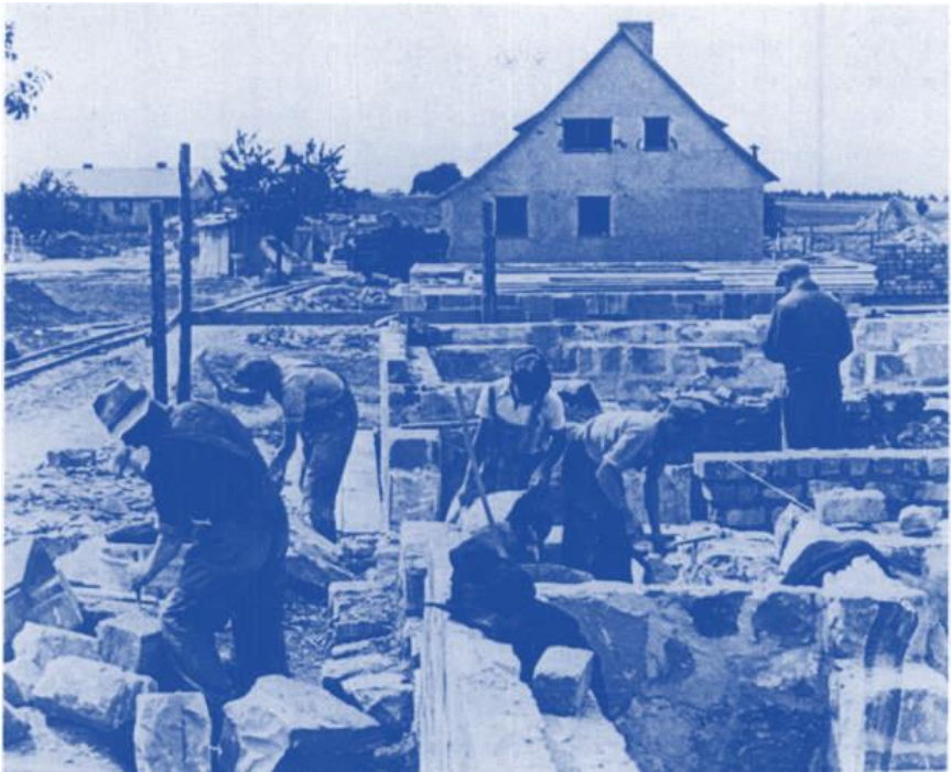
62 Neubürger beim Mauern der Fundamente für das erste Kassettenhaus aus Frankfurter Trümmersteinen auf dem Bad Vilbeler Heilsberg, 1948.
