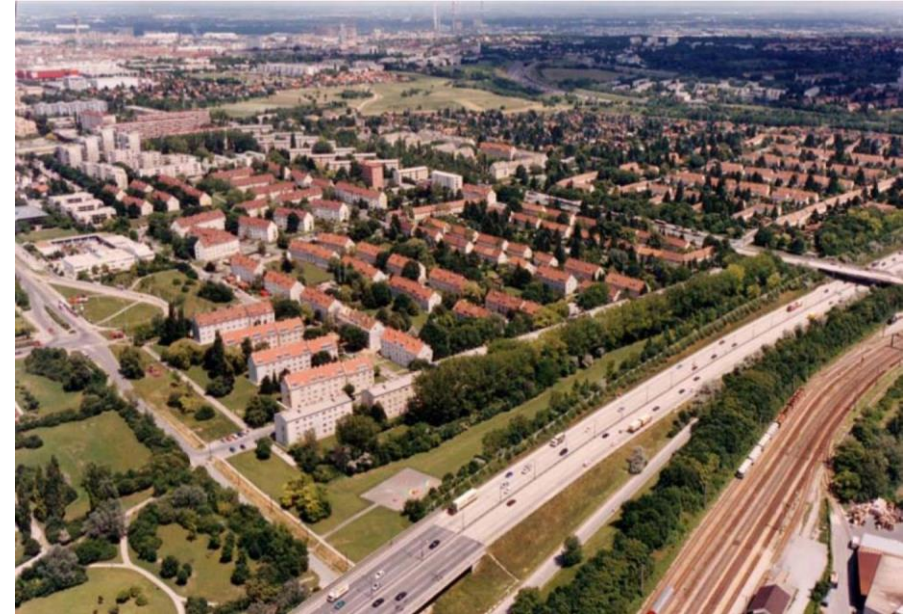
Abbildung 16: Per-Albin-Hansson-Siedlung West, das erste grosse Wohnbauvorhaben nach dem Zweiten Weltkrieg. Quelle: media wien
