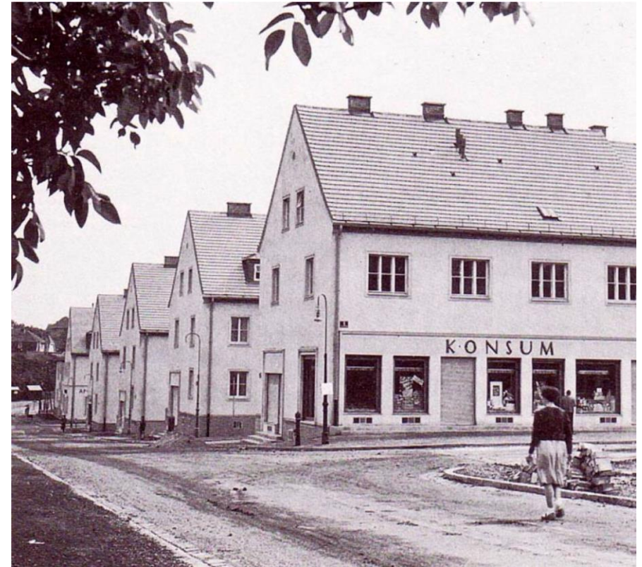
Abbildung 17: Die Kongresssiedlung in Hietzing, 1953 Quelle: 150 Jahre Wiener Stadtbaumeister, S. 105
