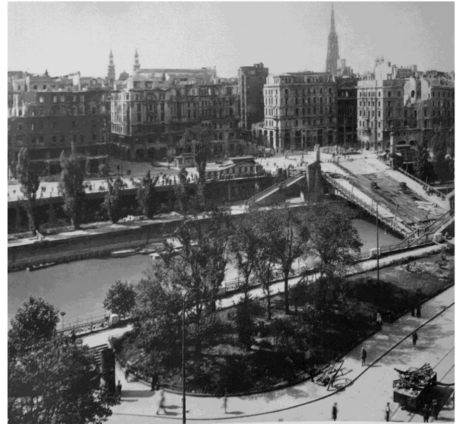
Abbildung 9: Zerstörte Marienbrücke über den Donaukanal. Quelle: Opll F., Wie Phönix aus der Asche . S. 64
