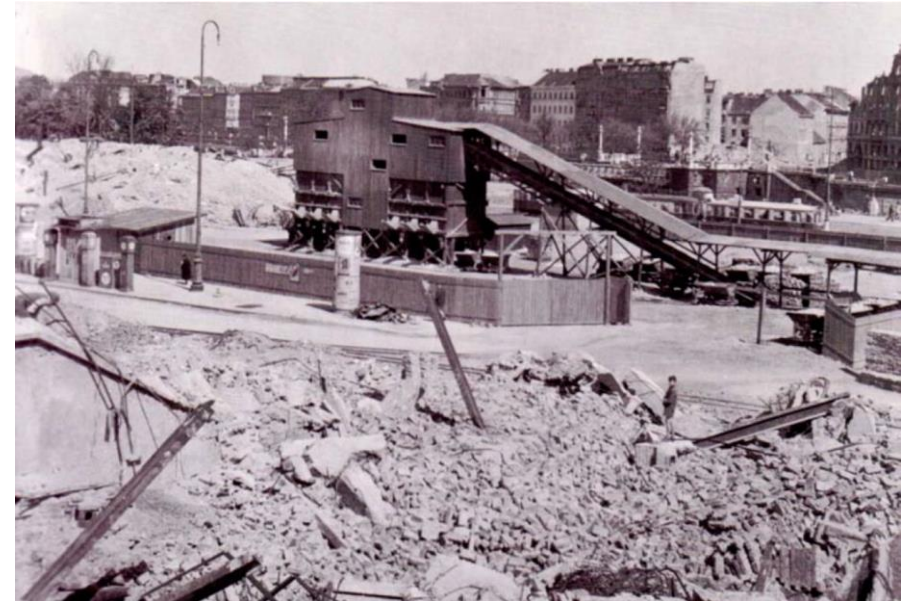
Abbildung 15: Die schwedische Maschinen-Konstruktion, mit der auf dem Franz-Josefs-Kai Bausteine aus dem Schutt gepresst wurden. Quelle: 150 Jahre Wiener Stadtbauamt. S.50
