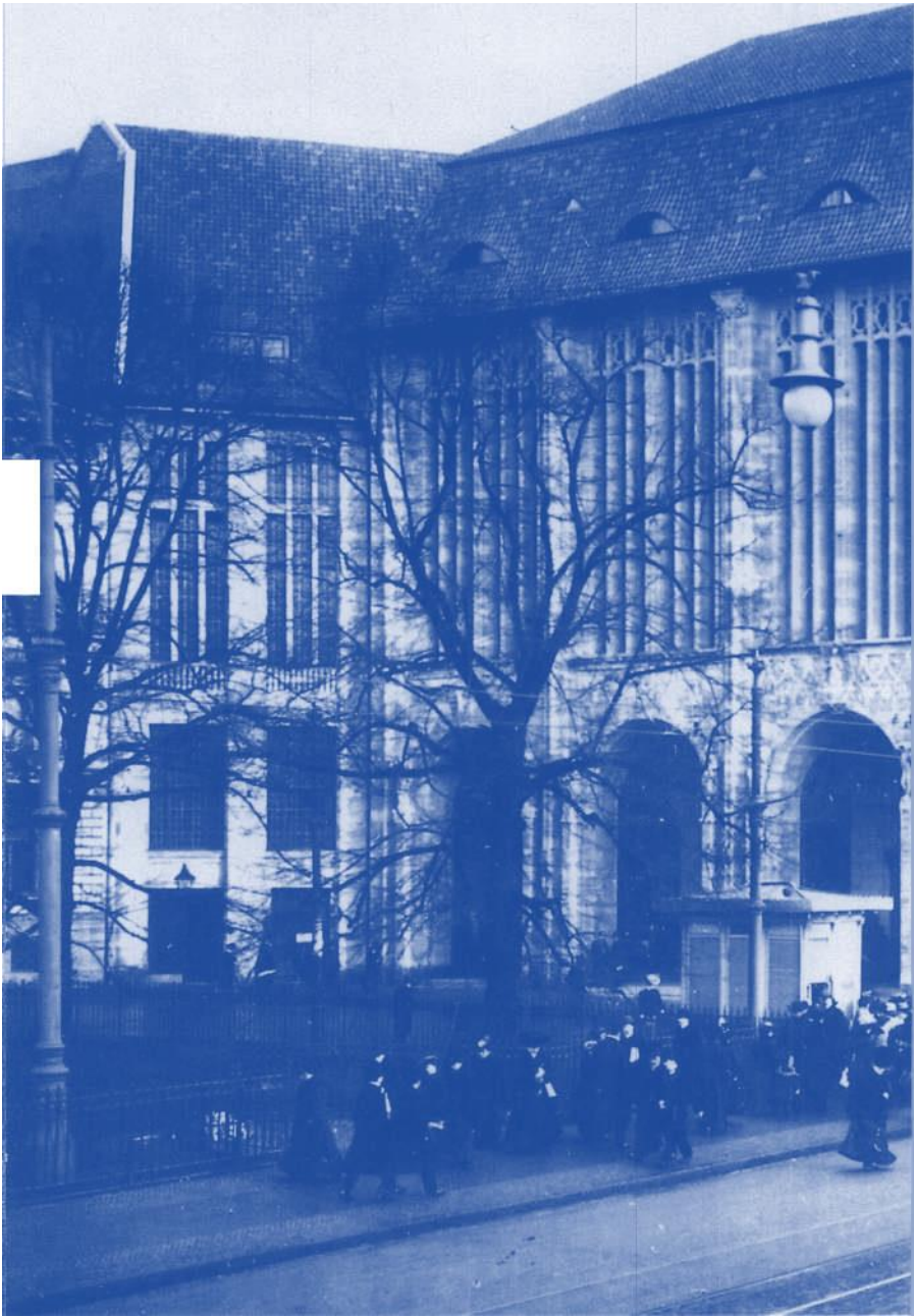
Das Kaufhaus Wertheim am Leipziger Platz war Alfred Messels Meisterwerk. Weit weniger beschädigt als das KaDeWe, wurde es nach dem Kriege abgerissen – niemand weiss mehr, warum.
